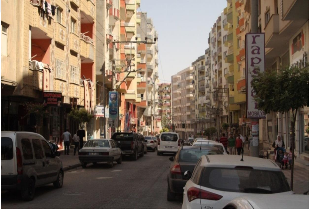
Fotoğraf 4. 7: Kilise Caddesinde Yapsatçılıkla Yükselen Apartmanlar
