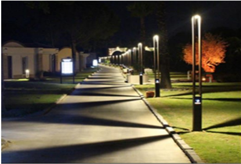
Resim 2.25. Otopark acil bağlantı aydınlatması
