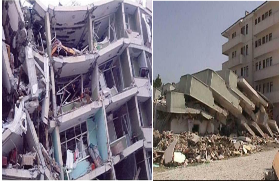
Şekil 1.1 : Kocaeli Depremi Sonrası Hasarlı yada Çökmüş Yapılar.(*)
