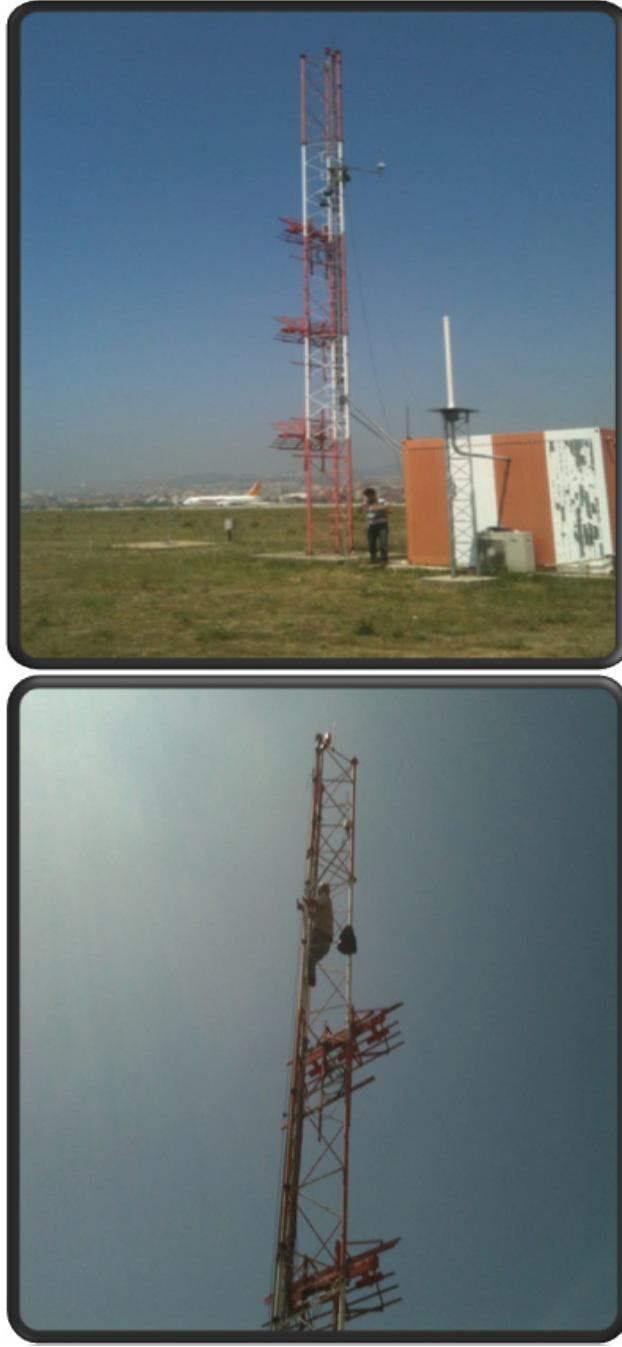
Şekil 3.4 : Rüzgâr hızı ölçüm cihazının Sabiha Gökçen Havalimanı'na kurulması.
