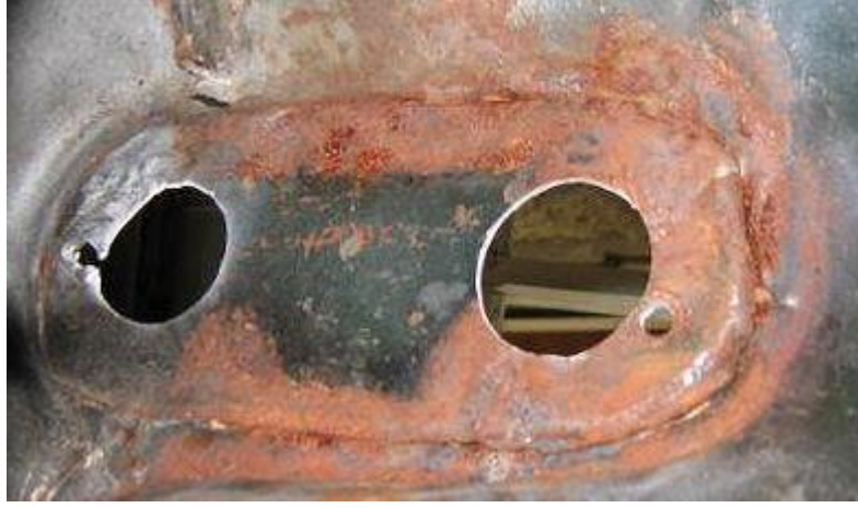
Şekil 2.17. Cıvatanın sebep olduğu aralık korozyonu (Anonim 2009)
