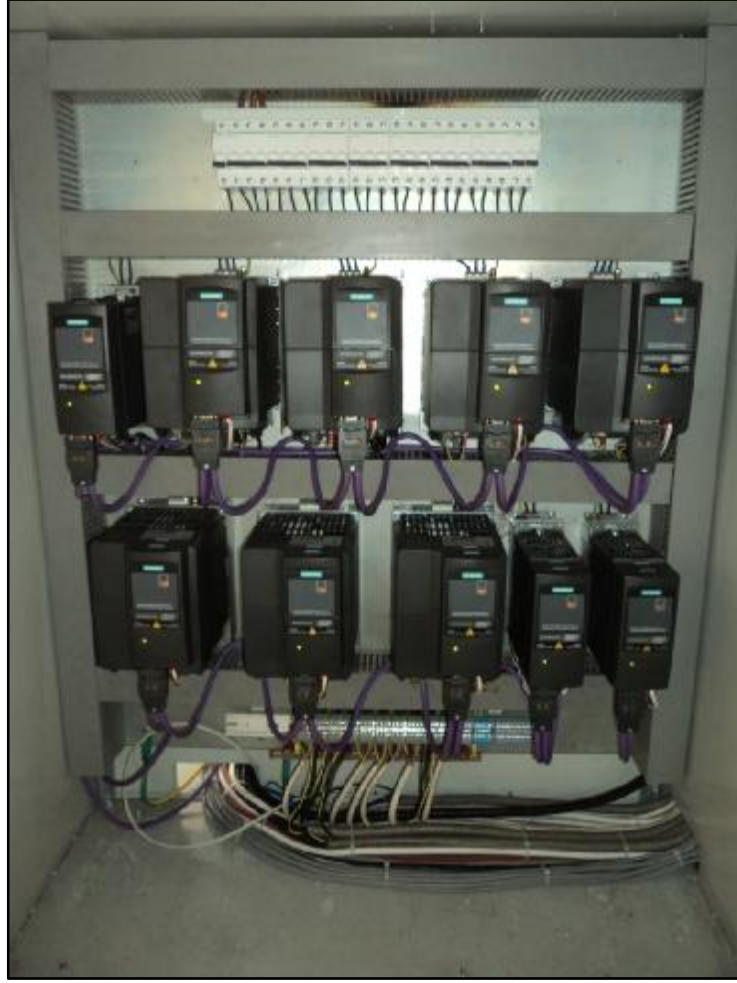
Şekil 4.31. Makinenin AC motor hız kontrol üniteleri
