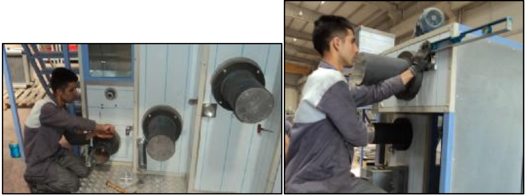
Şekil 4.19. Godetlerin makineye montajı
