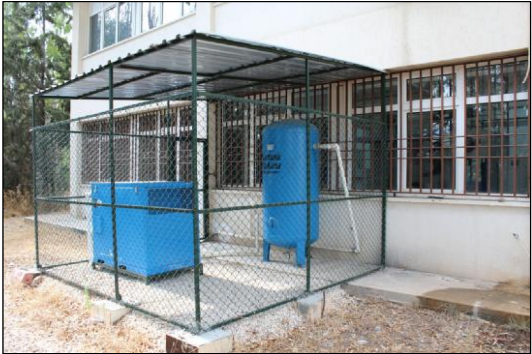
Şekil 4.35. Sürekli filament iplik üretim laboratuvarında kompresör yerleşimi
