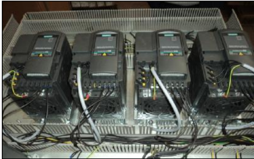
Şekil 4.28. Motor hız kontrol üniteleri
