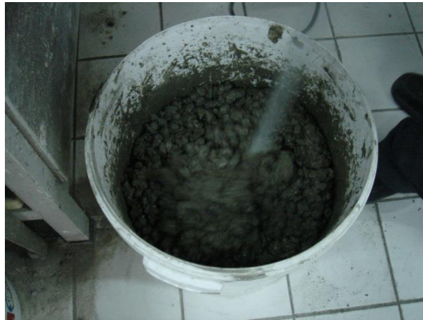
Şekil 3.12 : Beton karışımının hazırlanması.
