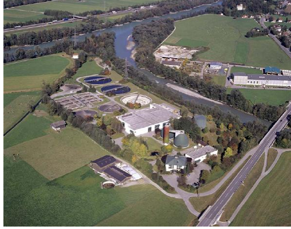
Şekil 3.17: Strass AAT görünüşü, 1996 ( http://www.aiz.at/klaeranlage.htm ).
