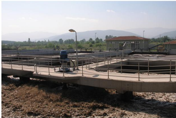
Şekil 5.6: Havalandırma havuzu görünümü.
