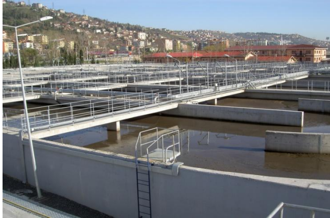
Şekil 5.2: Plajyolu AAT Anaerobik, Anoksik ve Aerobik Havuzları.
