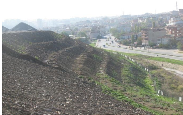
Şekil 4.34: Varyap Meridian şantiye alanı çevresinde toprak kayıplarına karşı eğimli yamaçlarda yapılan teraslamalar.
