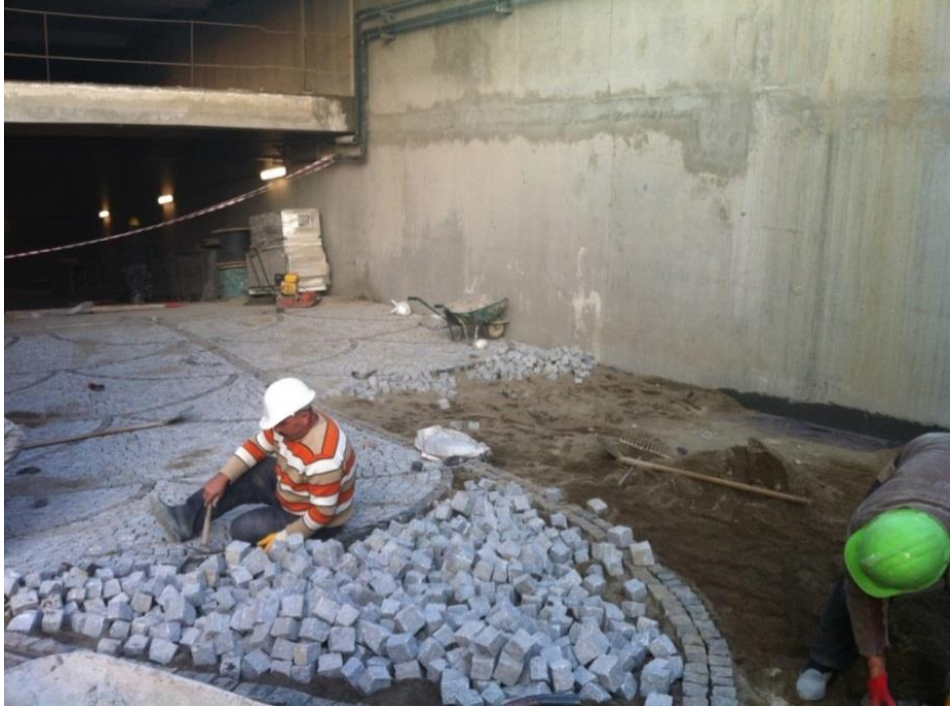
Şekil 4.19: Varyap Meridian Toplu Konut Alanı' ndaki araç yollarında harçlı granit küp taş uygulaması.
