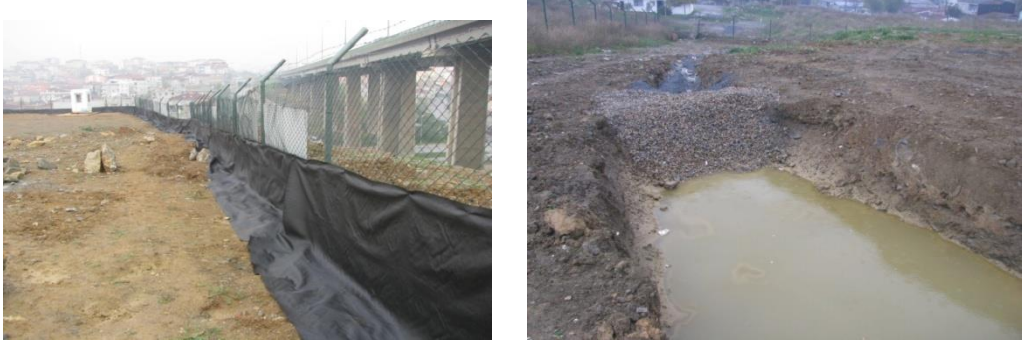
Şekil 4.32: Proje sahası çevresinin tekstil malzeme ile perdelenmesi ve su kanallarında toprak çökeltme sistemleri yapılması.
