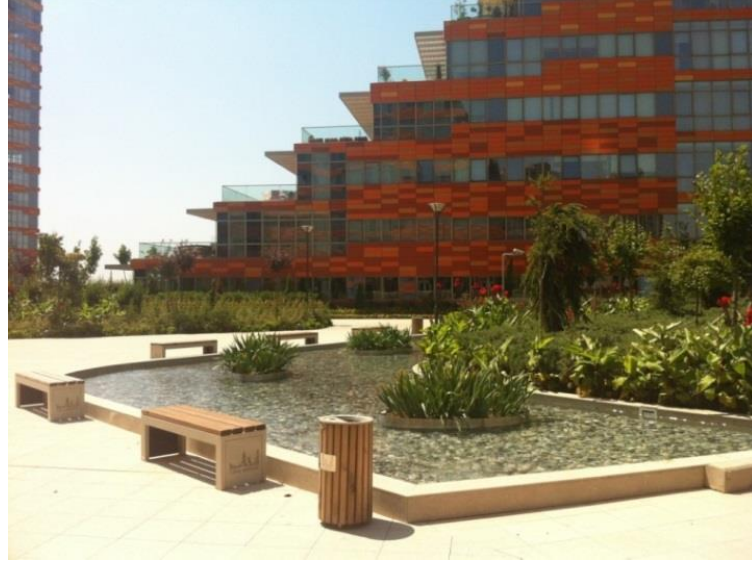
Şekil 4.22: Varyap Meridian Toplu Konut Alanı B blok süs havuzundan bir görünüş.
