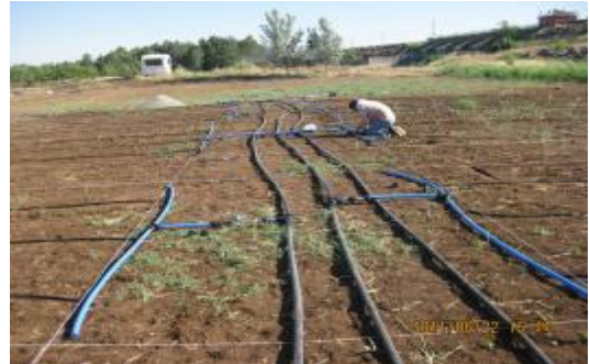
Resim 3.3. Damla sulama sisteminde kontrol ünitesi ve manifold boruların yerleştirilmesi
