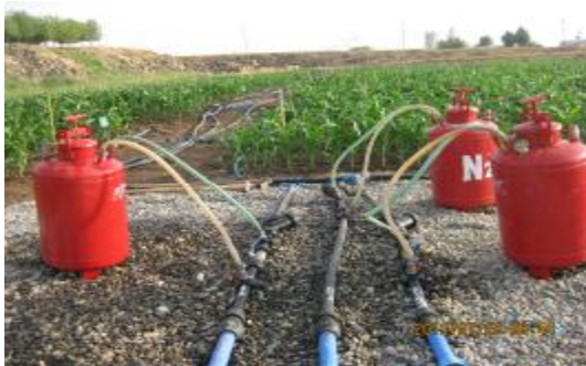
Resim 3.3. Damla sulama sisteminde kontrol ünitesi ve manifold boruların yerleştirilmesi
