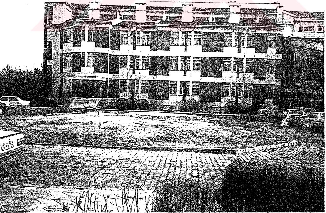
Mozalk Havuz Uygulama Mekanı
