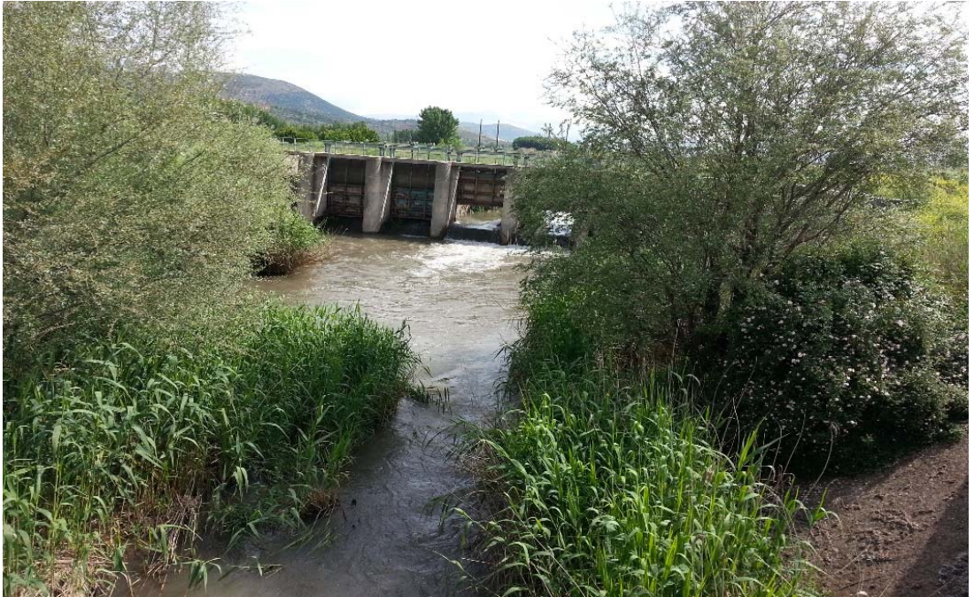
Şekil 4.7. Azaplı Kanal 2 istasyonu
