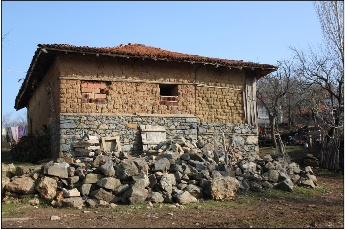
Fotoğraf4.3 Yapı malzemesi çeşitliliği olan bir ev eklentisi örneği (Hacılar Köyü, 2013)
