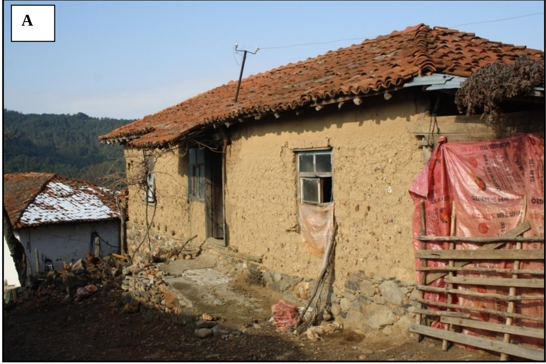
Fotoğraf 4.1. Yenice ilçesinde kır yerleşmelerinin büyük bölümü kerpiç evlerden oluşmaktadır. A:Hacılar Köyü (2013) B: Namazgah Köyü (2013)
