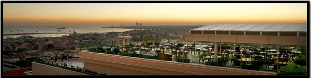
Şekil 5. 42 BW The President Otel çatı restoranı
