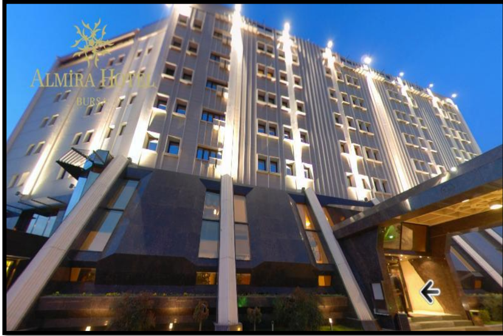
Şekil 5. 6 Almira otel ön cephe [88]
