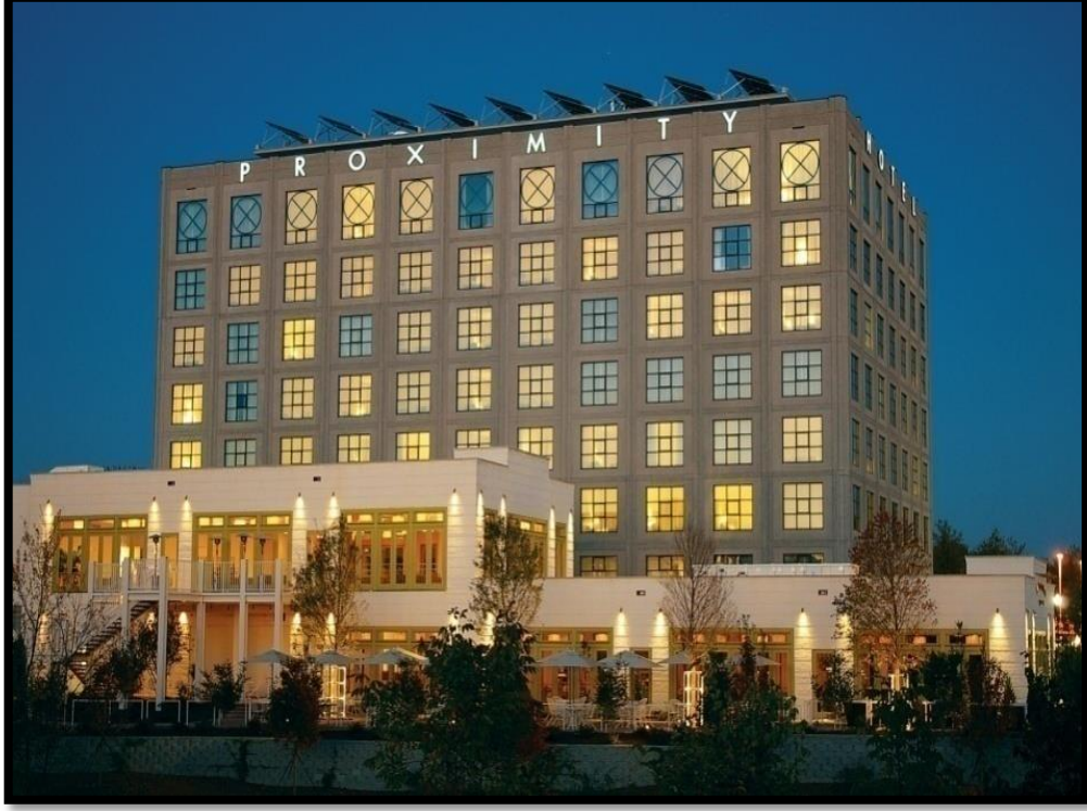
Şekil 3. 23 Proximity Hotel, kütleli otel cephe kullanımı ve güneş panelleri [57]
