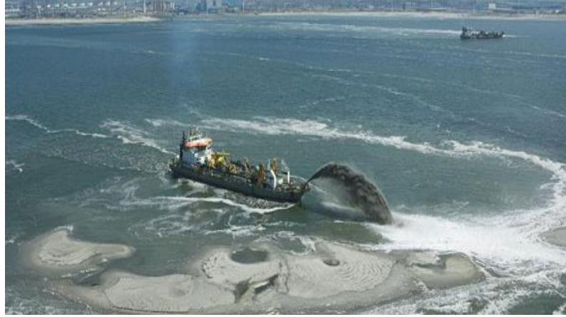
Foto 19. Gemi yardımıyla doldurma işlemi-Hollanda ( www.pprune.org )
