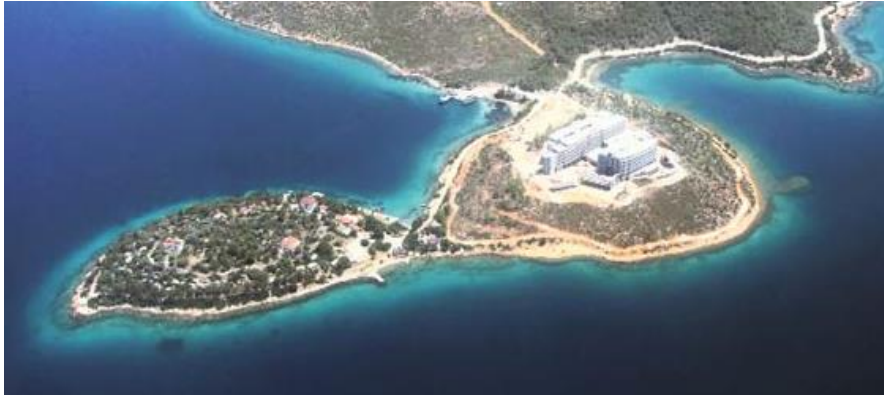
Foto 5. Pina yarımadasının dolgu işlemi ve inşaat sonrasındaki durumu (Milliyet Gazetesi 11.07.2012)
