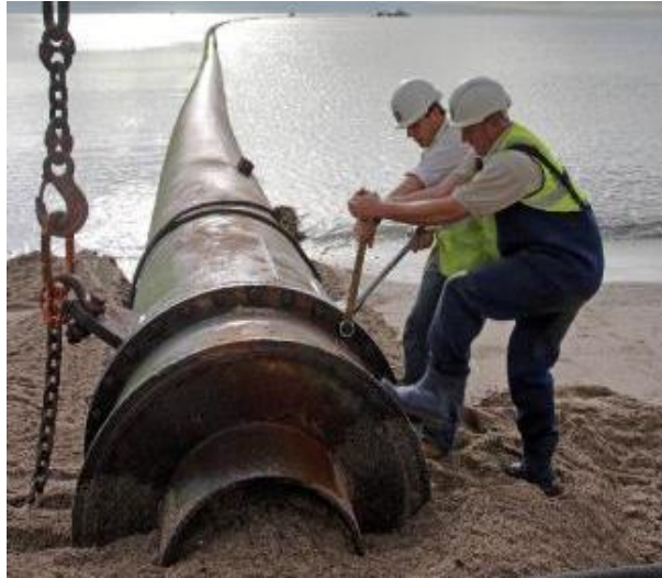
Foto 20. Derin denizden sahile borularla kum taşıma işlemi -Hollanda ( http://fundamentals-of--life.blogspot.com.tr/2010/03/land-reclamation.html )
