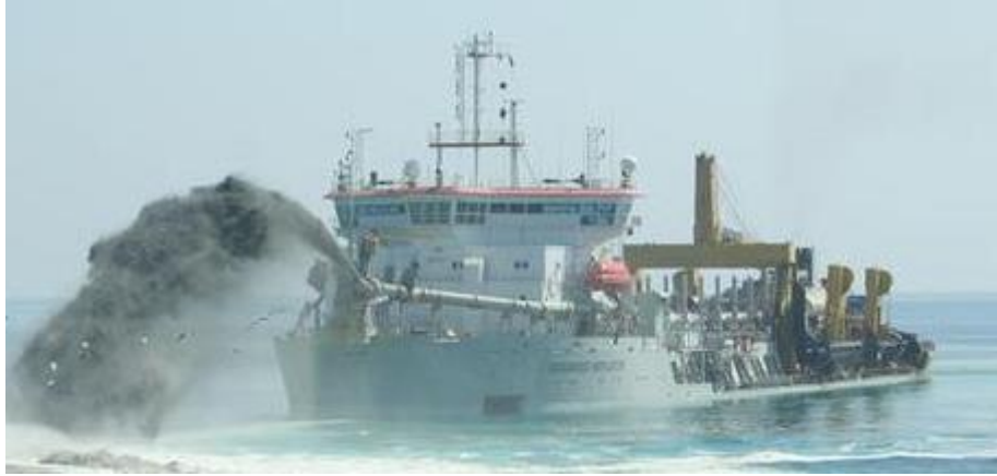
Foto 21. Gemi yardımıyla doldurma işlemi-Hollanda (www.dredgingtoday.com)
