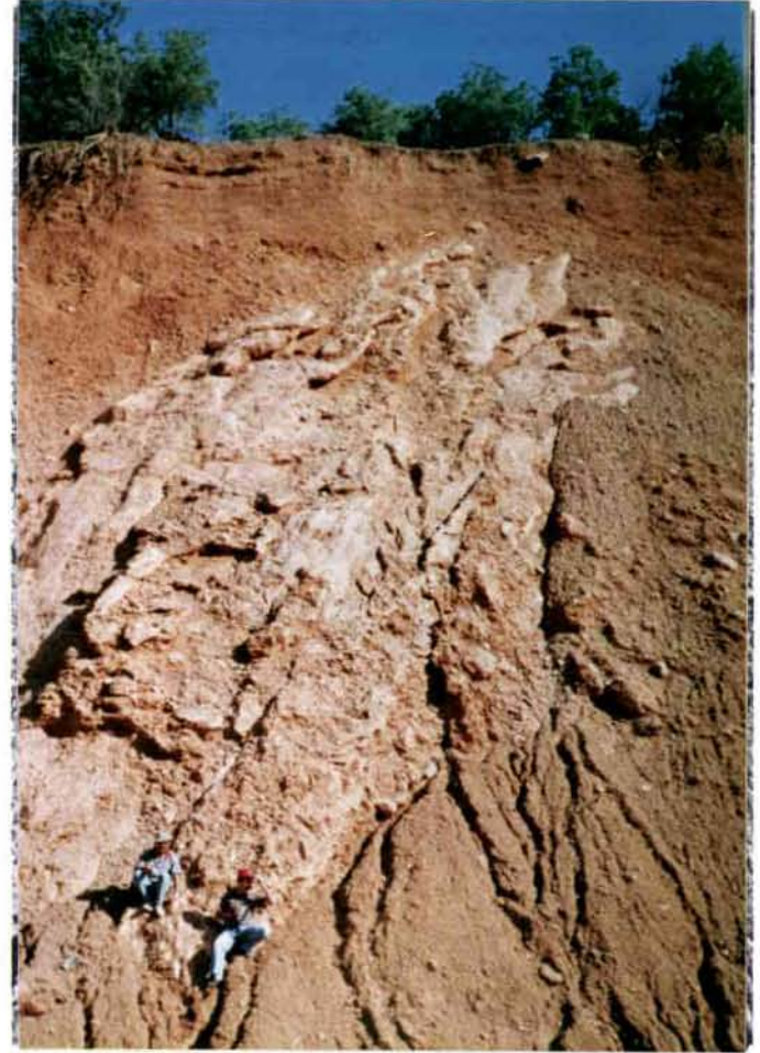
Foto 37: Kaplanlı-Yağcı Köyleri arasında yamaç enkazı ve enkaz içindeki traverten oluşumları.
