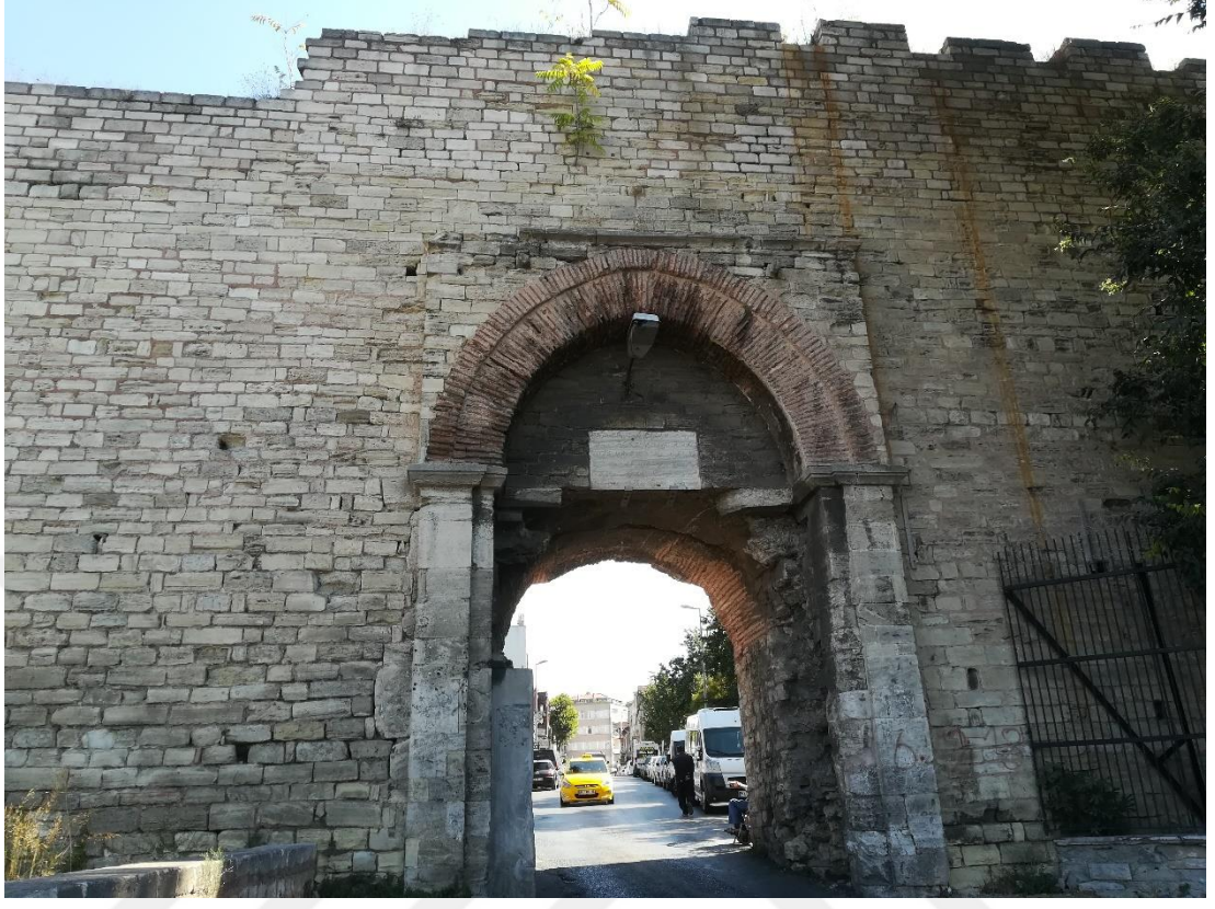
Görsel 33 Yedikule Kapısı (Murat KAYA 2023)
