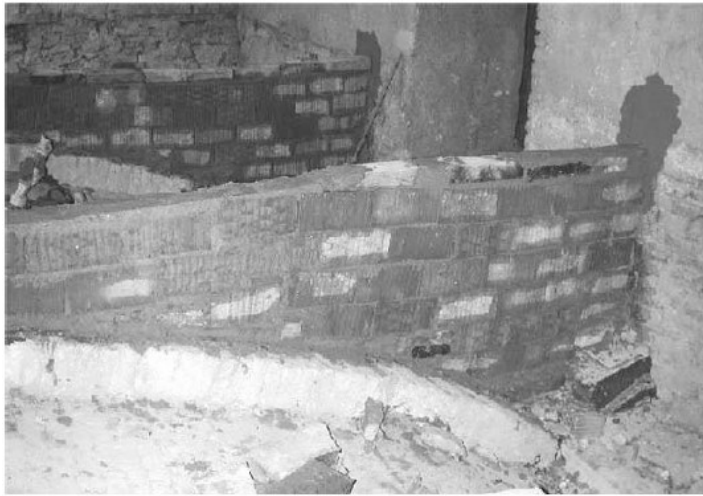
Şekil 2.7 Tonoz Güçlendirme Çalışması Uygulama Fotoğrafı (Bastianini, F., vd.)
