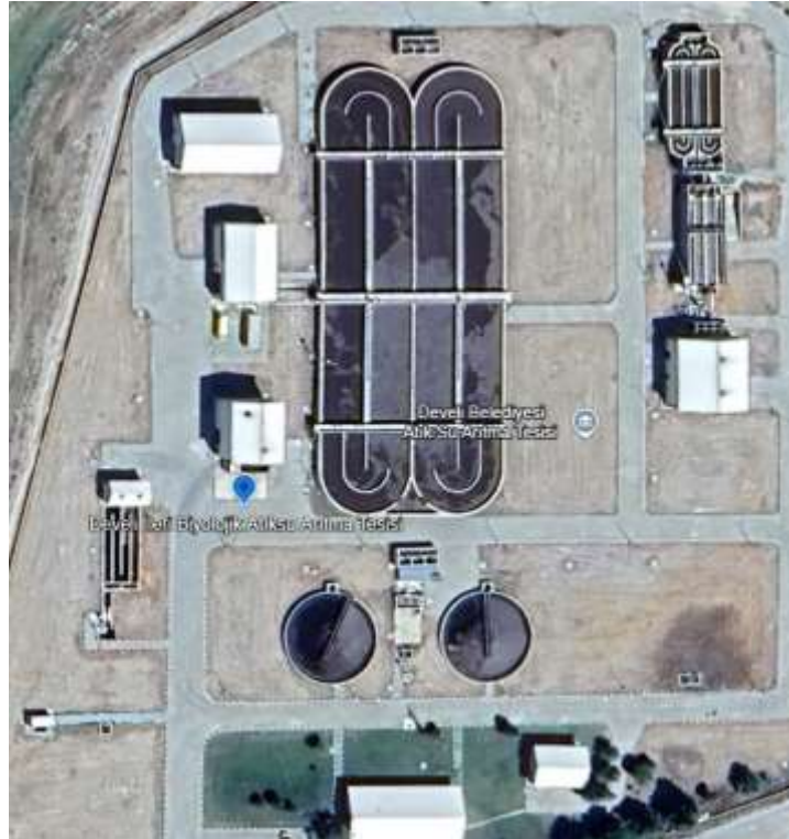
Şekil 3. Develi AAT ve Arıtma Çamurunun Alındığı Bölge (38°20'45"N 35°27'03"E)
