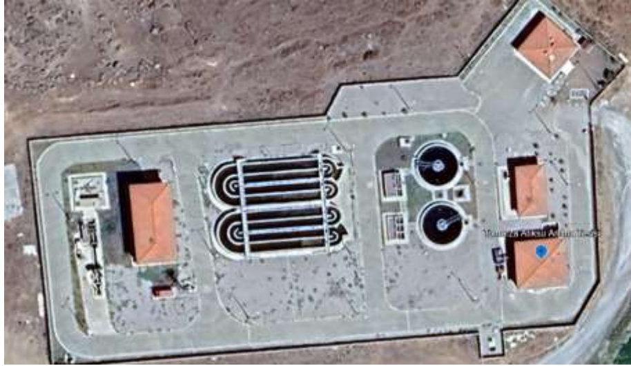
Şekil 7. Tomarza AAT ve Arıtma Çamurunun Alındığı Bölge (38°26'40"N 35°49'55"E)
