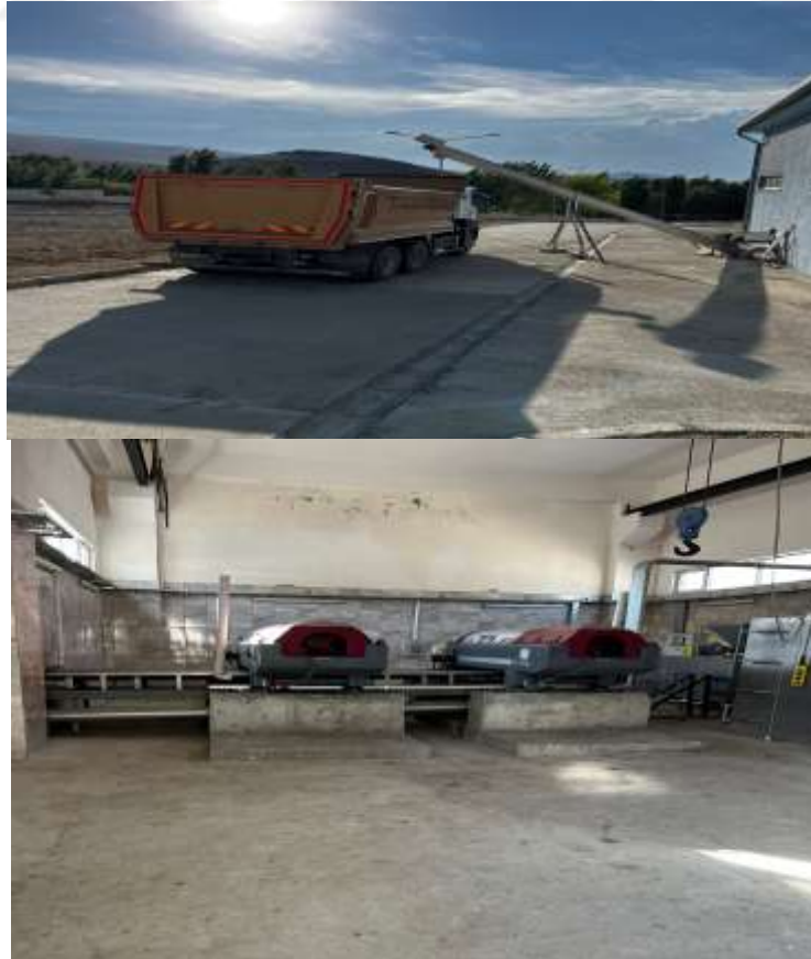
Şekil 10. Bünyan AAT Çamur Susuzlaştırma ve Dekantör Ünitesi
