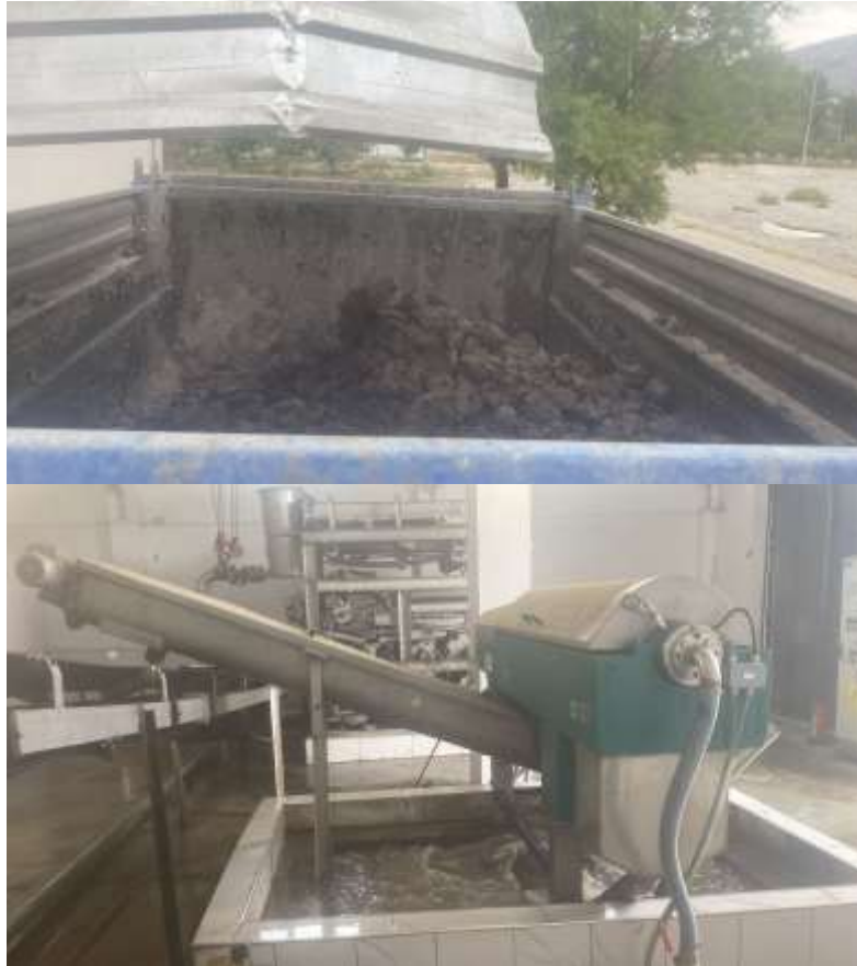
Şekil 6. Yahyalı AAT Çamur Susuzlaştırma ve Dekantör Ünitesi
