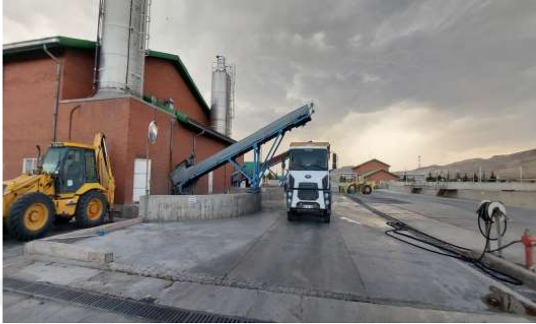
Şekil 2. KİBAAT AAT Çamur Susuzlaştırma ve Beltpres Ünitesi
