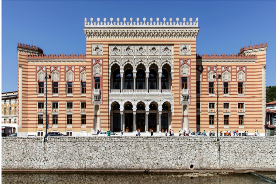
Şekil 3.6: Saraybosna belediye binasından kütüphaneye dönüşüm (Erhardsson, 2020).
