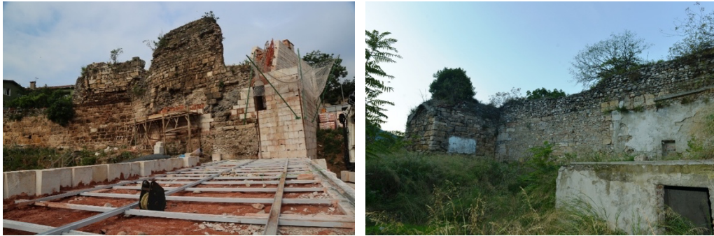
Şekil 6.16: Zindan Kapı restorasyon öncesi (BBB arşivi).
