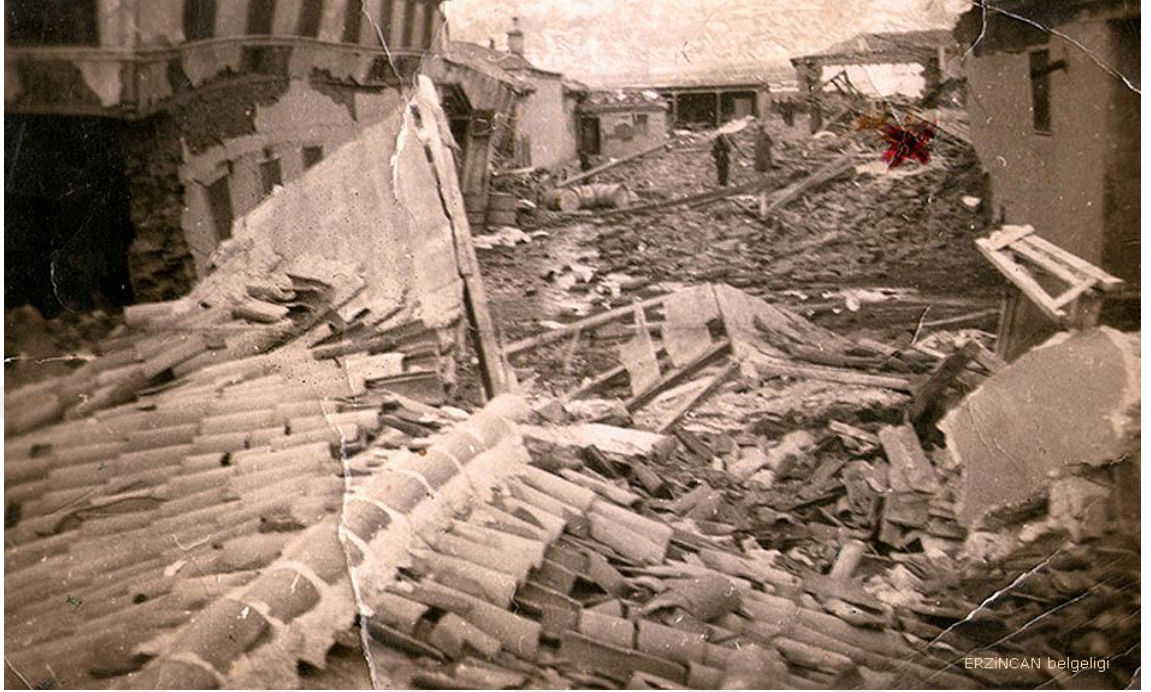
Görsel 18: Erzincan Askeri Ortaokulu Binasının Despremden sonraki hali (mimoza., tarihsiz)
