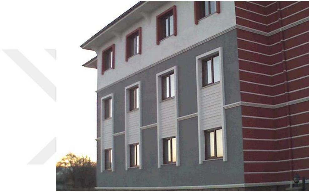
Şekil 5.11: XPS ısı yalıtımı uygulanmış binanın dış cephe görünüşü [32].
