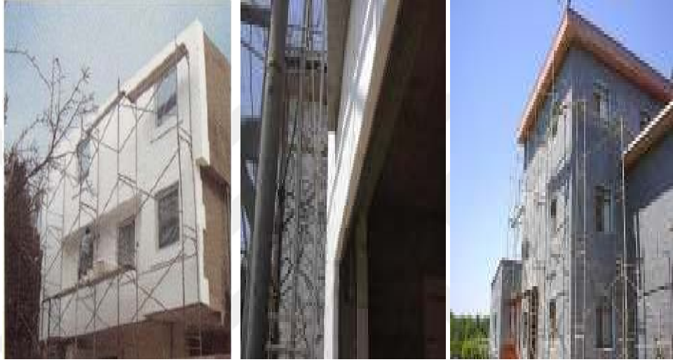
Şekil 3.13: Ekspande polistiren köpüğün dış duvar ısı yalıtılması [6]
