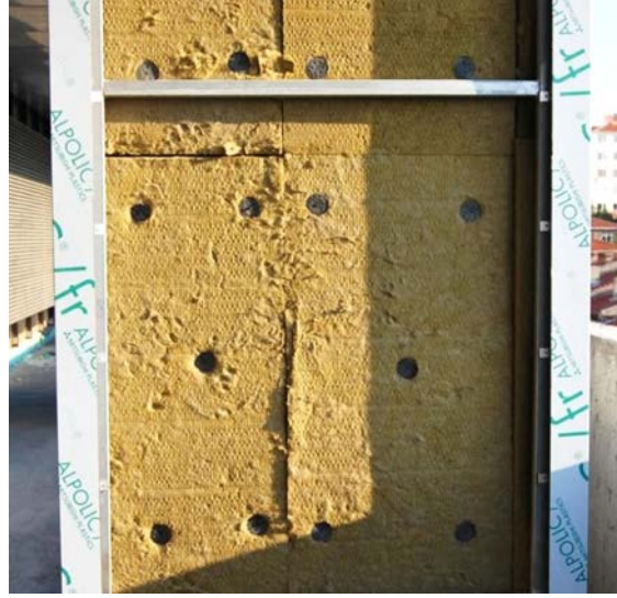
Şekil 3.4: Yarı esnek formda üretilmiş taş yünü malzemesi [30]
