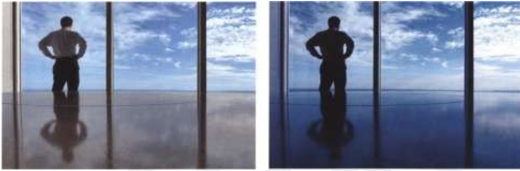
Şekil 4.12: Sağ tarafta güneş korumalı olan camın ışık geçirgenliği gösterilmiştir [12]
