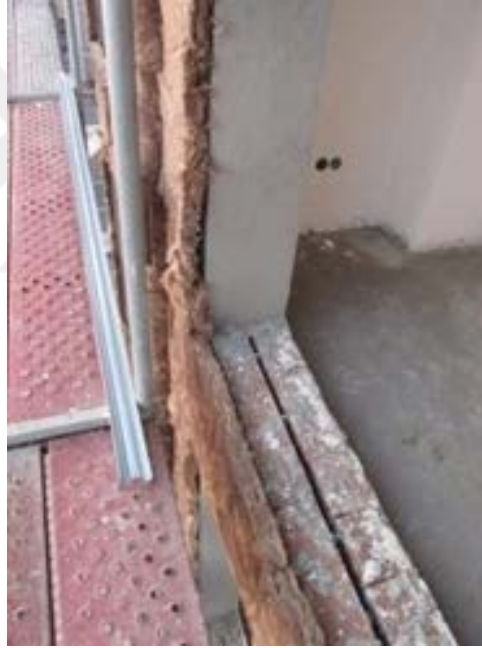
Şekil 5.10: Sarıyer bölgesinde yapılan bina uygulamasının pencere kenarlarında tam olarak yapılmaması [30].
