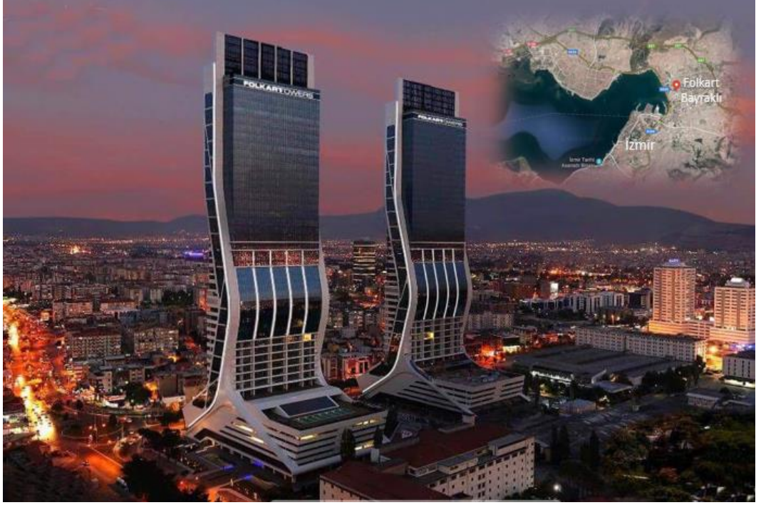
Foto 10: Merkezi iş alanına yakın güvenli ve prestijli konut talebi sonucu 2014 yılında inşa edilen Folkart Bayraklı, kapalı yerleşmelerin sadece kent çeperi ile sınırlı kalmayıp kent merkezinde de her hangi bir yerde karşımıza çıkabileceğini göstermektedir (Rezervebest, 26.10.2019).
