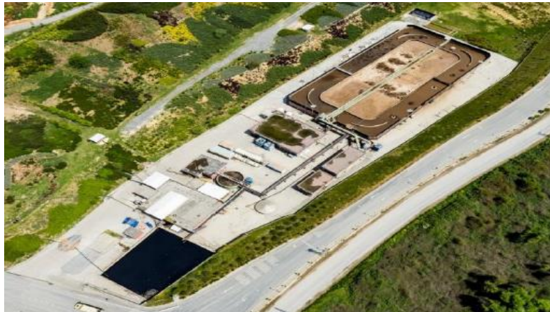
Şekil 4.1 Arıtma tesisi genel görünüşü
