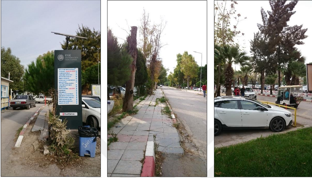
Şekil 46 [B.6] ve [B.5] alanlarında ulaşım ağı üzerine fiziksel engelli kullanıcılara yönelik kaldırımlarda rampaların problemleri -solda ve ortada- ve [B.1] hastane içerisindeki ring sistemine engelleyen araç park etme problemi -sağda- (Özgün, 2019)
