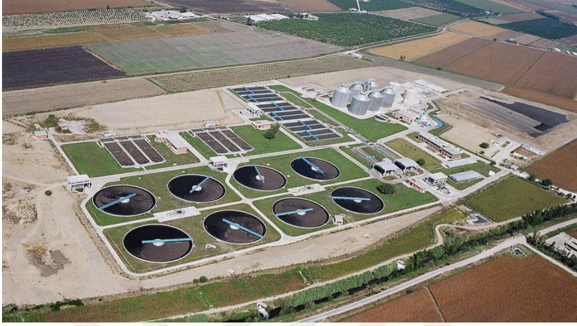
Resim 3.2. Seyhan atıksu arıtma tesisi (Adana-Türkiye) [57]
