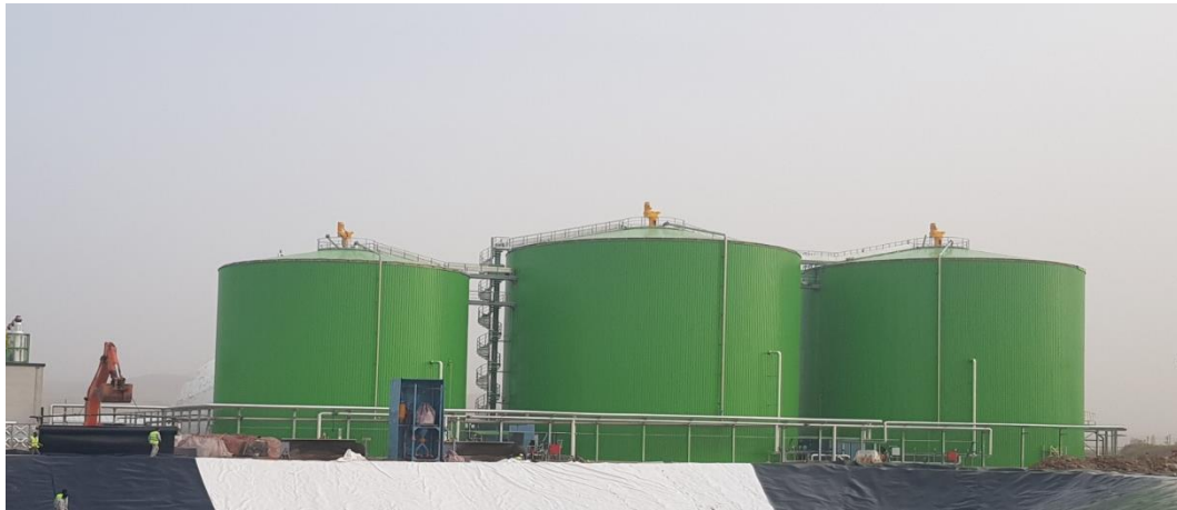
Resim 5.8. De Solar 7 Biyogaz Enerji Santralinde bulunan çürütücü ve hidroliz tankları
