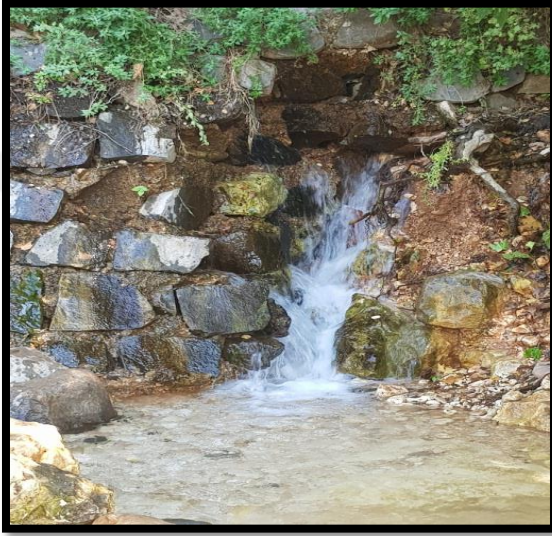
Foto 14. Geçmişte Kabtaja Alınmış Ancak Günümüzde Kullanılmadığı İçin Kabtaj Alanından Sızan Direkli Kaynağı
