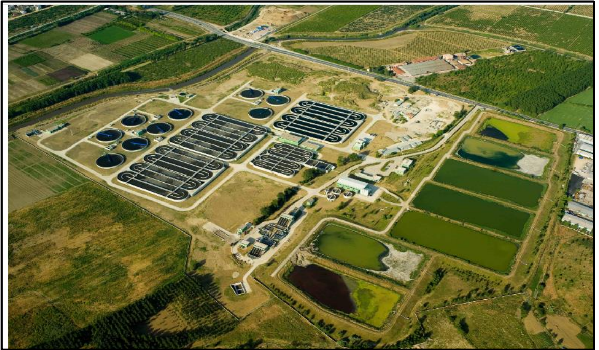
Şekil 4.1. Doğu Atıksu Arıtma Tesis görünümü ( https://www.kuzugrup.com/proje/buski-dogu-atıksu-arıtma-tesisi/ .)
