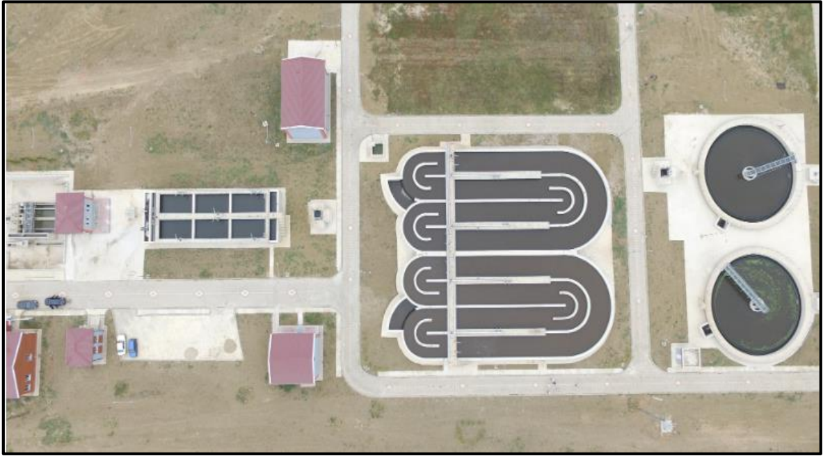
Şekil 4.8. Yenişehir İleri Biyolojik Atıksu Arıtma Tesis görünümü ( https://www.buski.gov.tr/tr/icerik/dogu_atik_su_aritma_tesis_575 )
