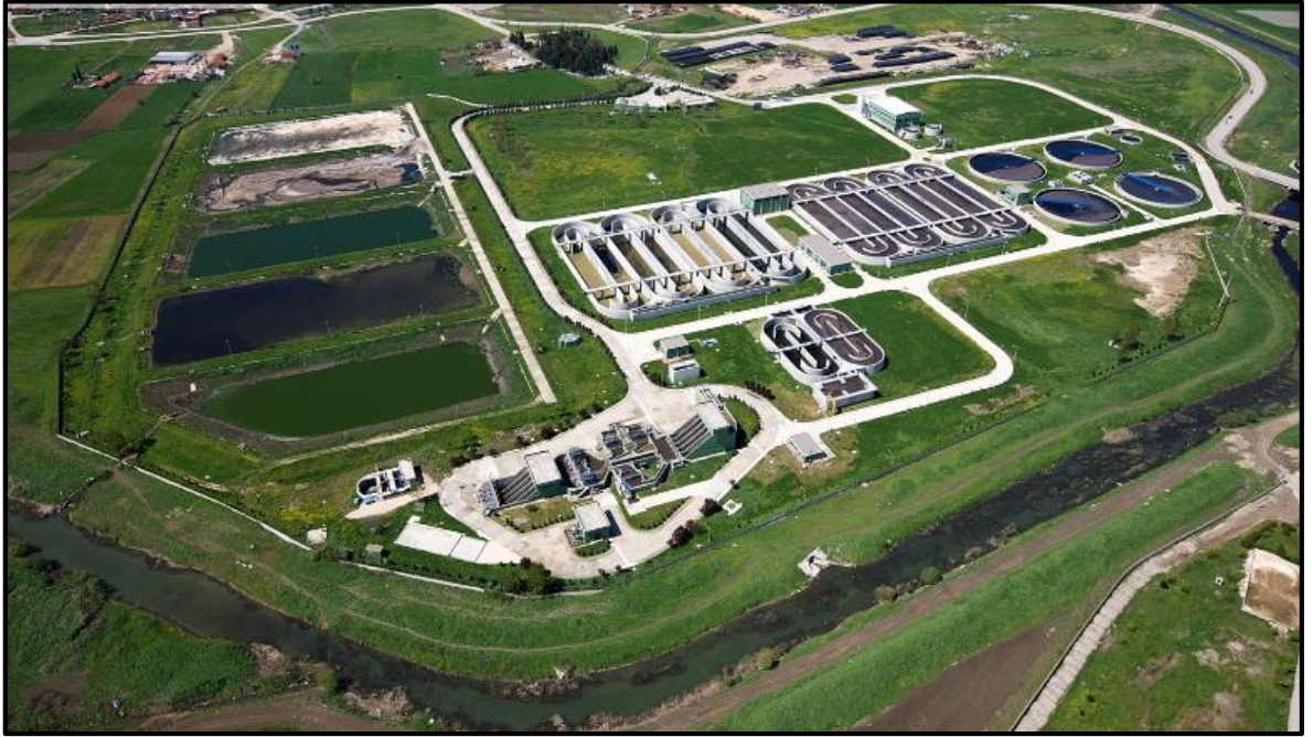
Şekil 4.3. Batı Atıksu Arıtma Tesis görünümü ( https://www.kuzugrup.com/proje/buski-bati-atiksu-aritma-tesisi/ .)
