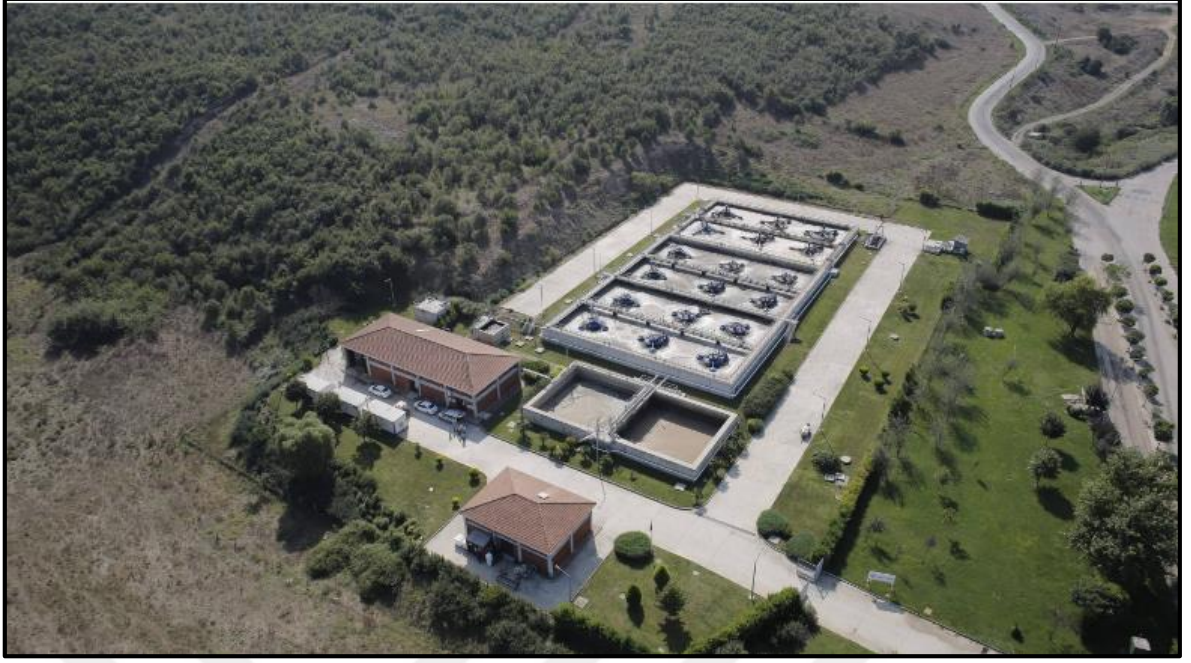
Şekil 4.4. Hamitler Kentsel Katı Atık Süzüntü Suyu Arıtma Tesis görünümü ( https://www.kuzugrup.com/proje/buski-kent-kati-atik-suzuntu-suyu-aritma-tesisi-ve-desarj-hatti/ .)
