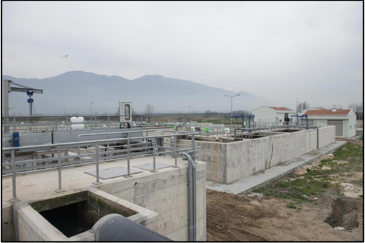
Şekil 4.6. Orhangazi İleri Biyolojik Atıksu Arıtma Tesis görünümü ( http://projeler.bursa.bel.tr/orhangazi-ileri-biyolojik-atıksu-arıtma-tesisi.html )
