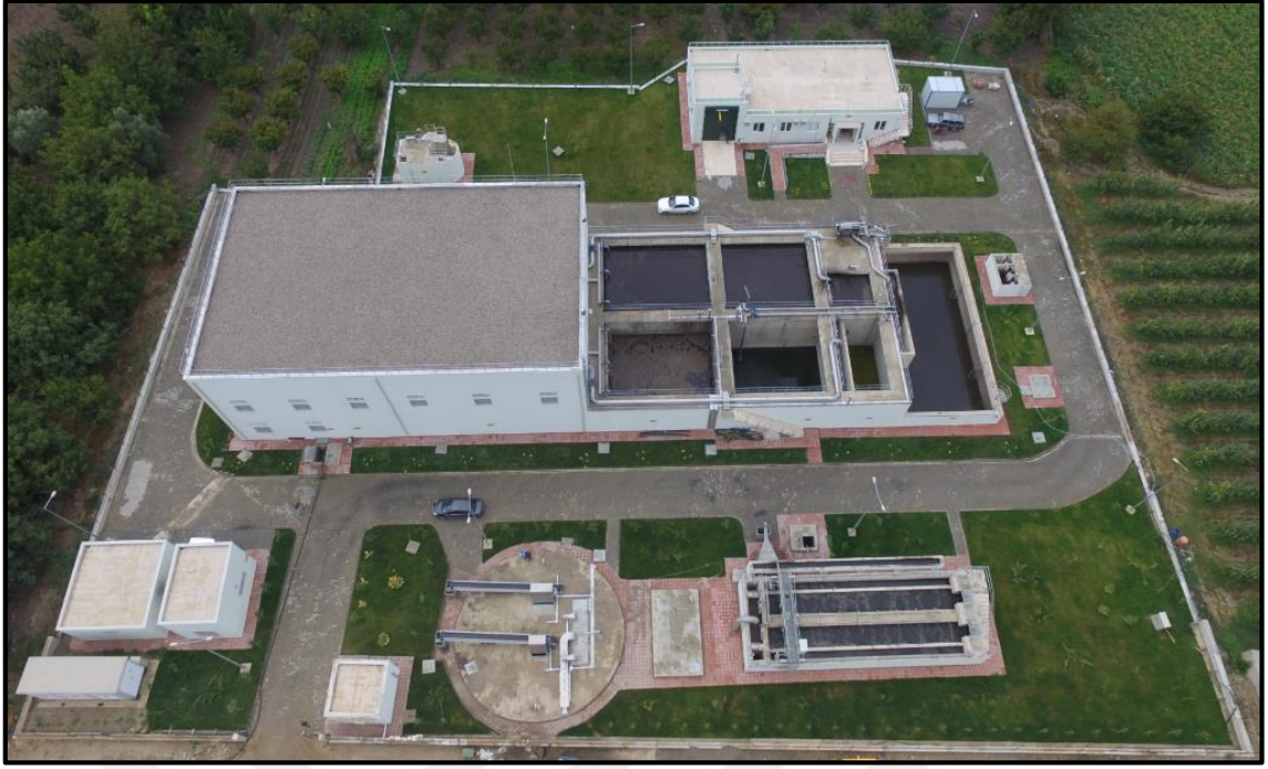
Şekil 4.7. İzmit Bursa MBR Teknolojili Atıksu Arıtma tesis görünümü ( https://www.buski.gov.tr/tr/icerik/dogu_atik_su_aritma_tesisi_575 )
