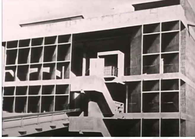
řekil 76. Deęirmen Sahipleri Derneęi Binası ve “iskele efekti”, Le Corbusier – 1954/ Entretien Sur Le B  ton , 1969
