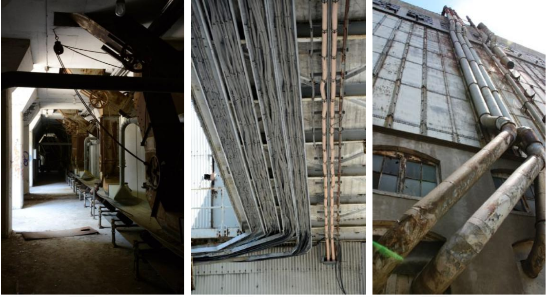
Şekil 4.41. Silophone / Silo yapısında ses iletim elemanları
