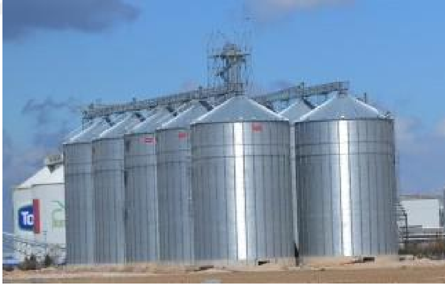
Şekil 3.25. Konya’da çelik tahıl silo yapısı
