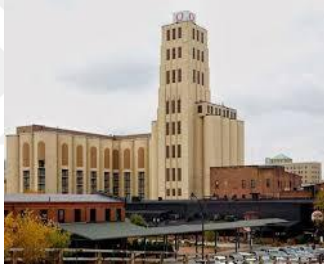
Şekil 3.22. Ohio/ ABD ‘de Quaker Meydanı’nda, 1932 yılında yapılmış yulaf silo yapısı
