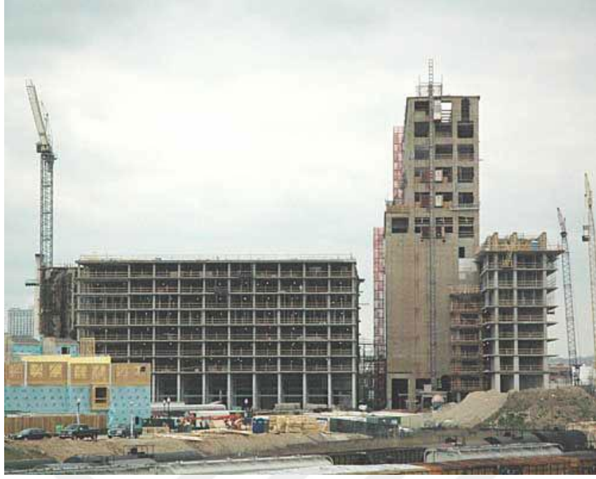
Şekil 4.29. Silo Point / İnşa aşaması
