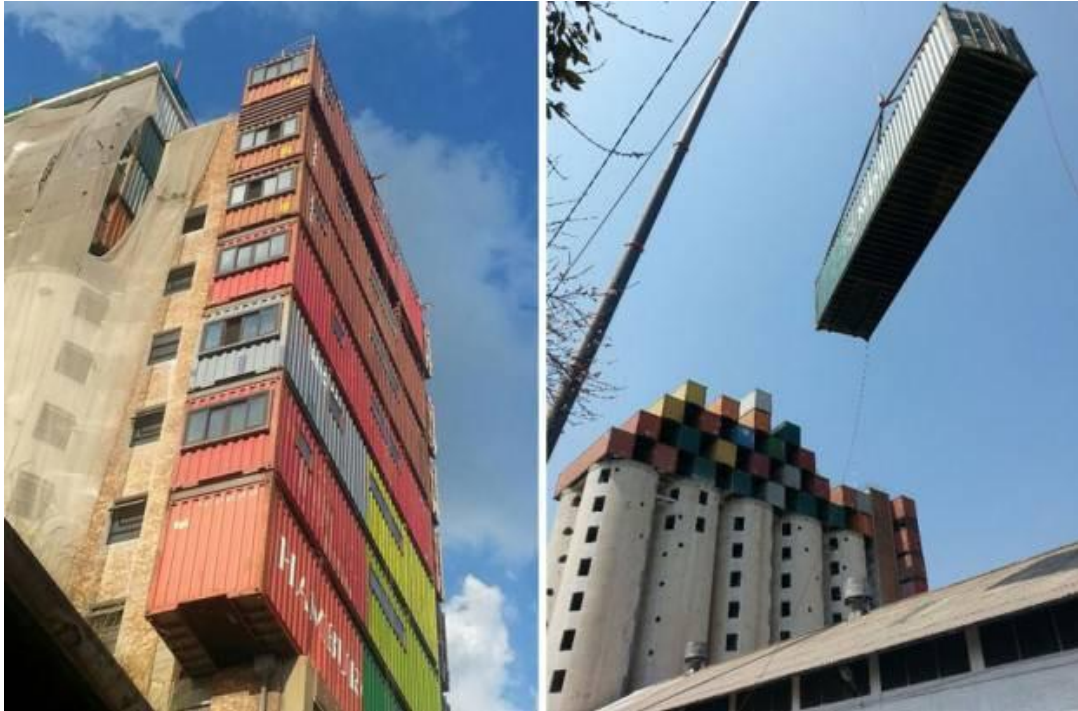
Şekil 4.51. The Mill Junction / Nakliye konteynırların yapıya eklenmesi
