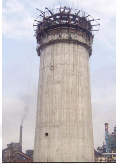
Şekil 3.7. Kayar kalıp yöntemi ile inşa edilen silo örneği /Azerbaycan Bakü Çimento Silosu (Yerli, 2013)
