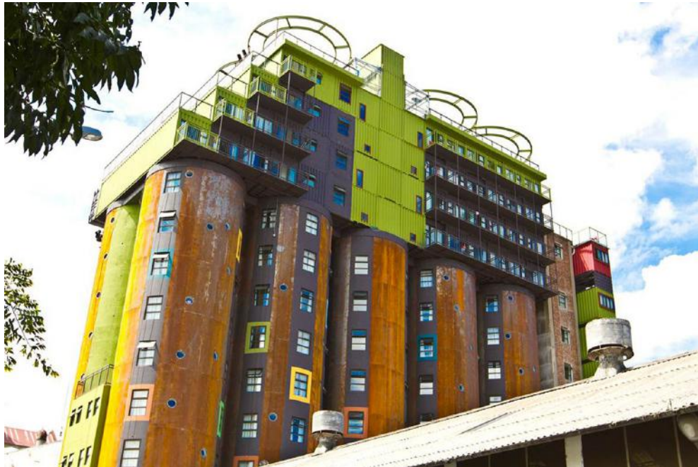
Şekil 4.52. The Mill Junction / Cephe
