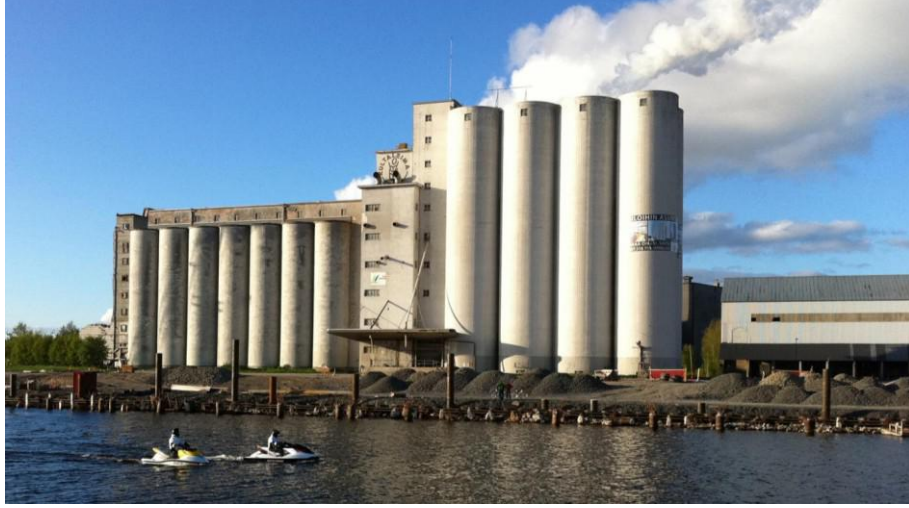
Şekil 3.24. Oulu /Finlandiya’da betonarme tahıl silo yapısı
