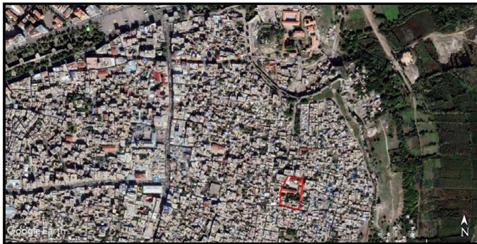
Şekil 4.42. Fatihpaşa Mahallesi'ndeki Emniyet Hizmet Alanının 2014 Yılına Ait Tahribat Öncesi Durumu [112]
