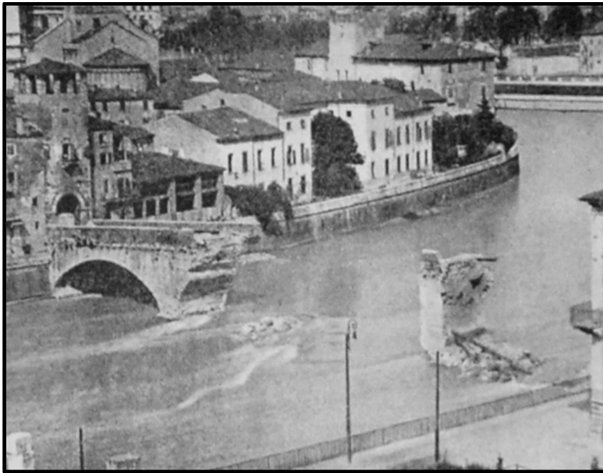
Şekil 2.5. Verona Kenti Pietra Köprüsü ve Çevresine Ait Yıkım Sonrası Görşeli [50]
