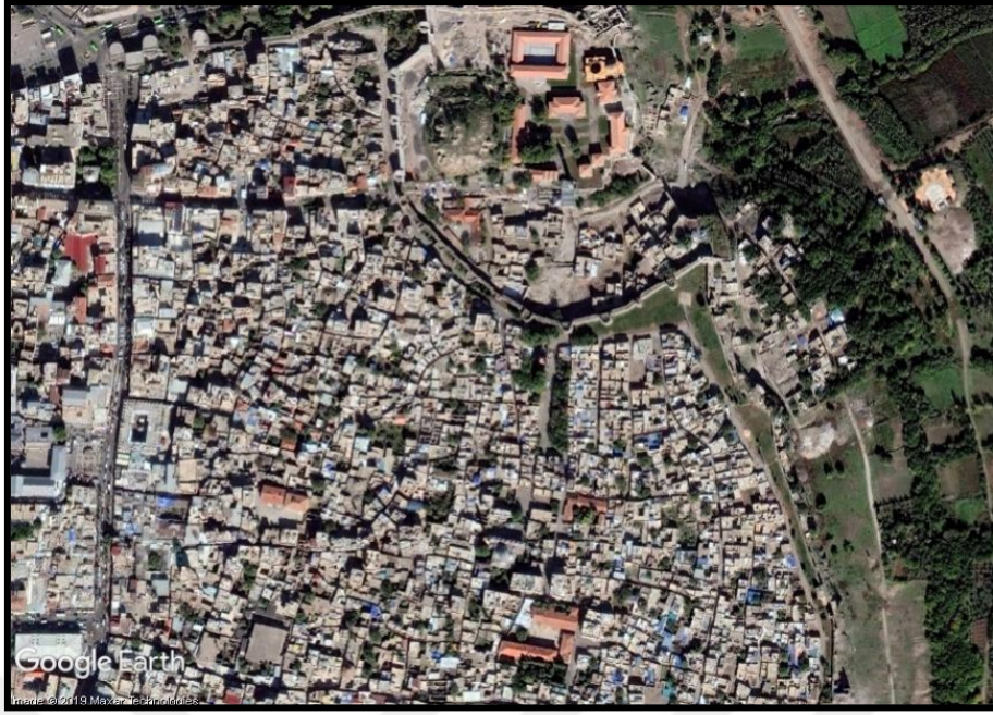
Şekil 5.8. Fatihpaşa Mahallesi 2014 yılı tahribat öncesi durumu gösteren hava fotoğrafı [112]
