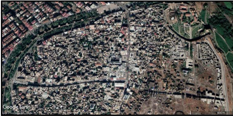
Şekil 4.46. Melikahmet Mahallesi'ndeki Emniyet Hizmet Alanının Tahribat Sonrası Durumu, 2019 [112]
