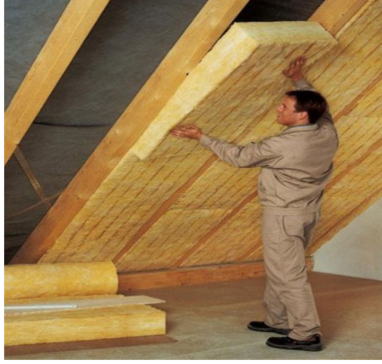
Şekil 2.10: Cam yünü uygulaması [38].
