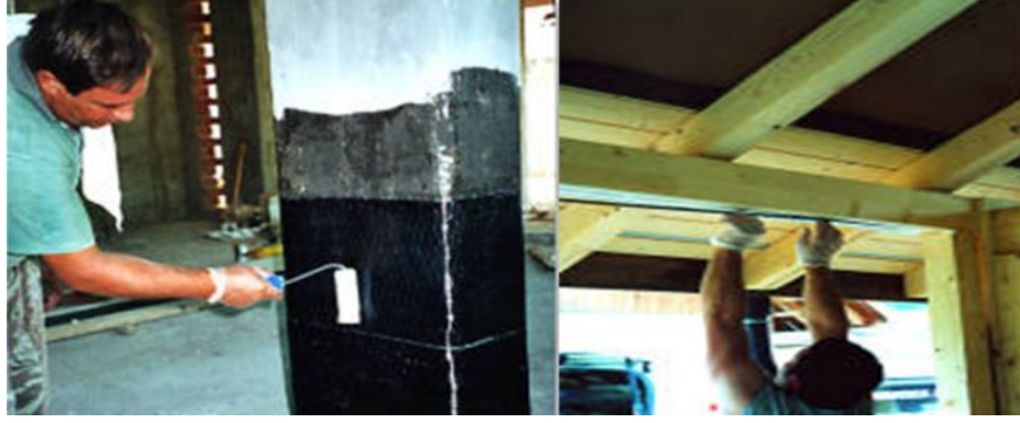
Şekil 3.7. FRP ile betonarme ve ahşap yapı güçlendirilmesi [59].
