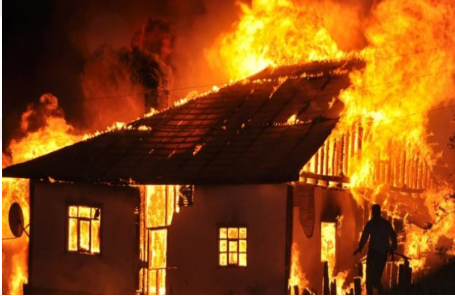
Şekil 1.1: Binada meydana gelen yangın [1].
