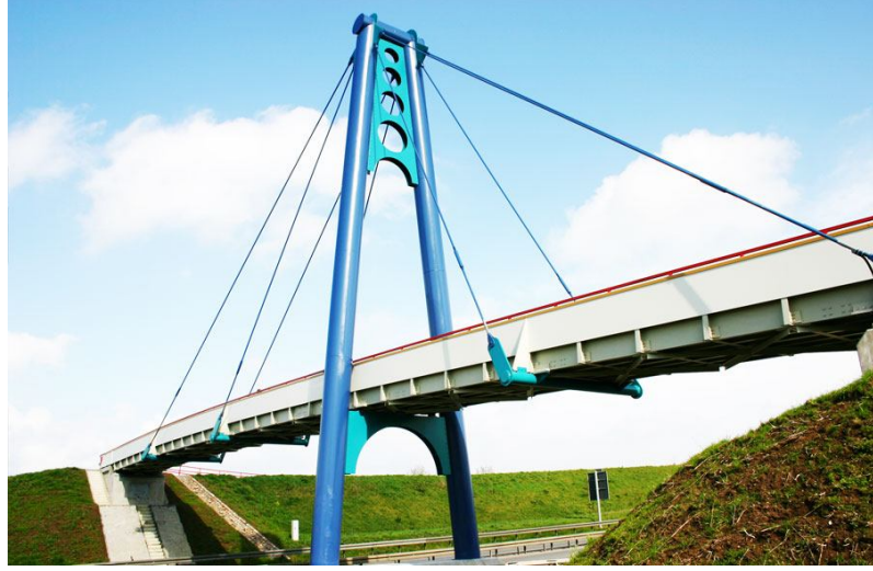
Şekil 3.6: FRP yaya ve hafif taşıt köprüsü [63].
