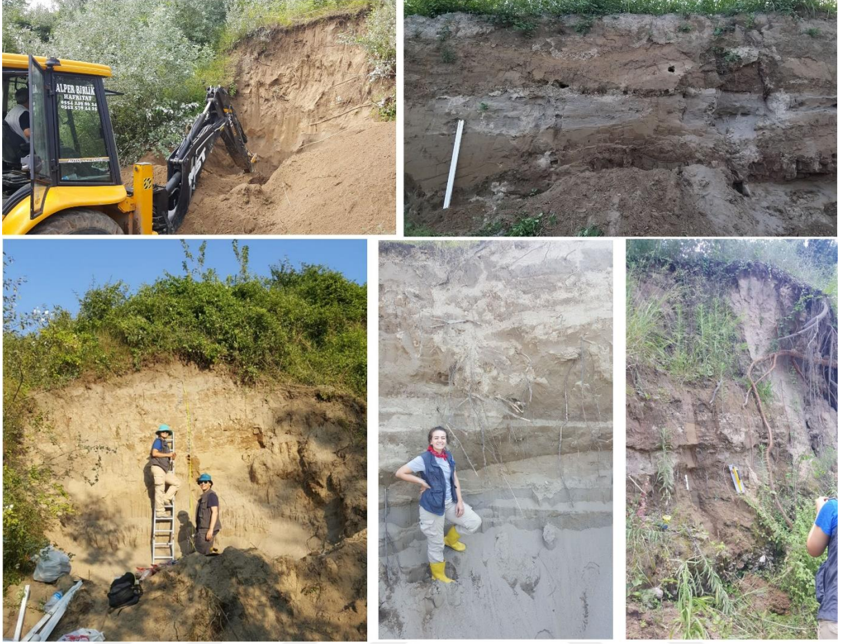
Şekil 21: Kesitlerin temizlenmesi ve ölçülmesi çalışmaları.
