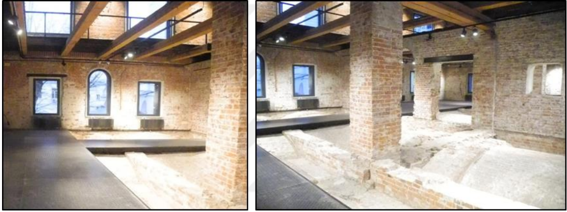
Şekil 6. Yenilenmiş Virane Kanat
