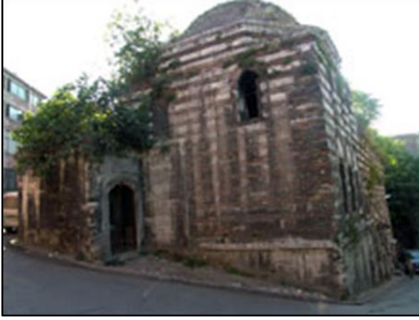
Şekil 31. Siyavuş Paşa Medresesi
