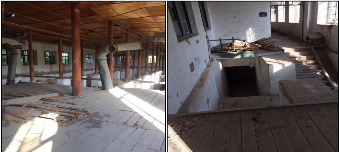
Fotoğraf 3.7 Fabrika merkez binası ve ana bina 1. kat girişi 2. katının görünüşü
