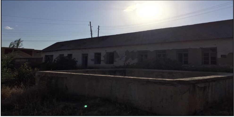
Fotoğraf 3.8 Ordubad İpek Koza Fabrikası imalathane binası
