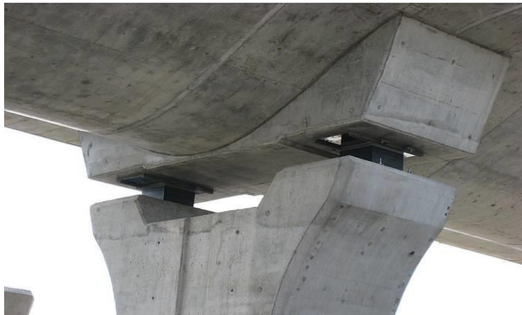
Şekil 4.1: Bir köprü ayağında kullanılan elastomer mesnet örneği
