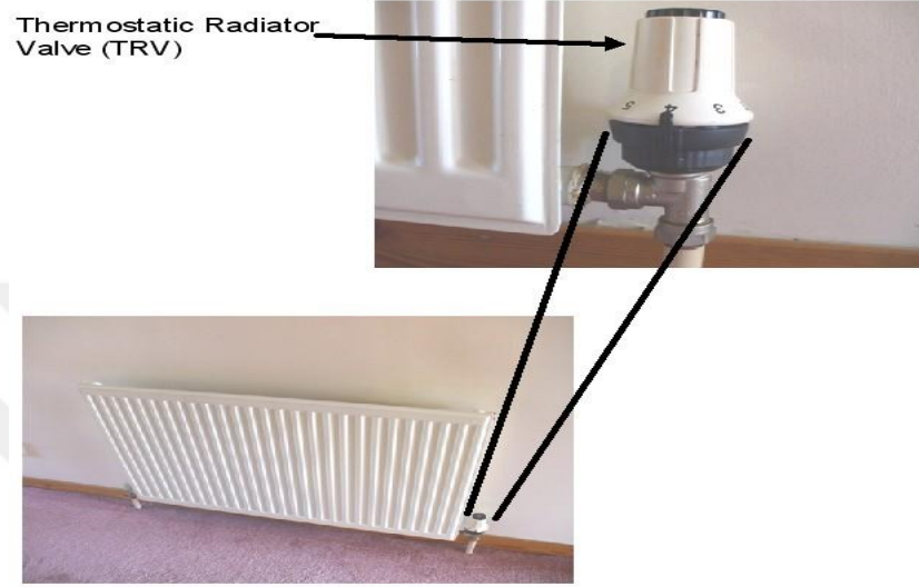
Şekil 1.9. Radyatörün vanası manuel olarak ayarlanması [53]
