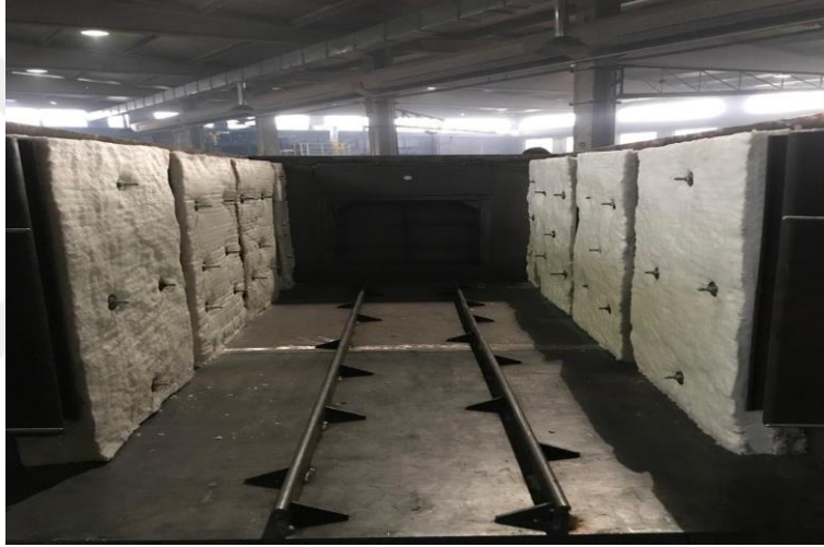
Resim 4.16 Isıl işlem fırını yalıtımı montaj resmi-3.
