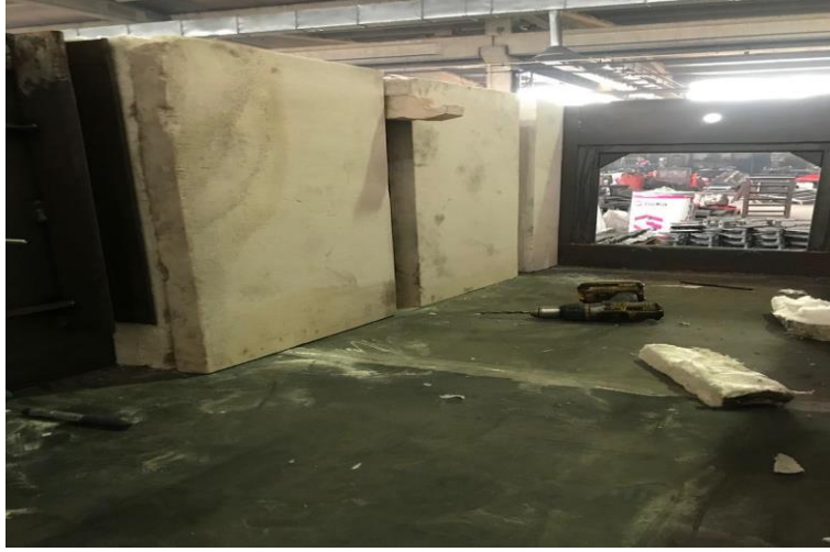
Resim 4.15 Isıl işlem fırını yalıtımı montaj resmi-2.
