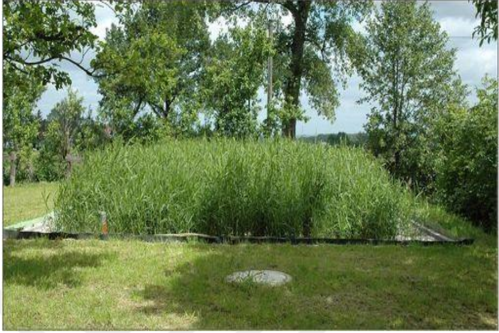
Şekil 1.6. Yeraltı akışkanlı yapay sulak alan örneği
