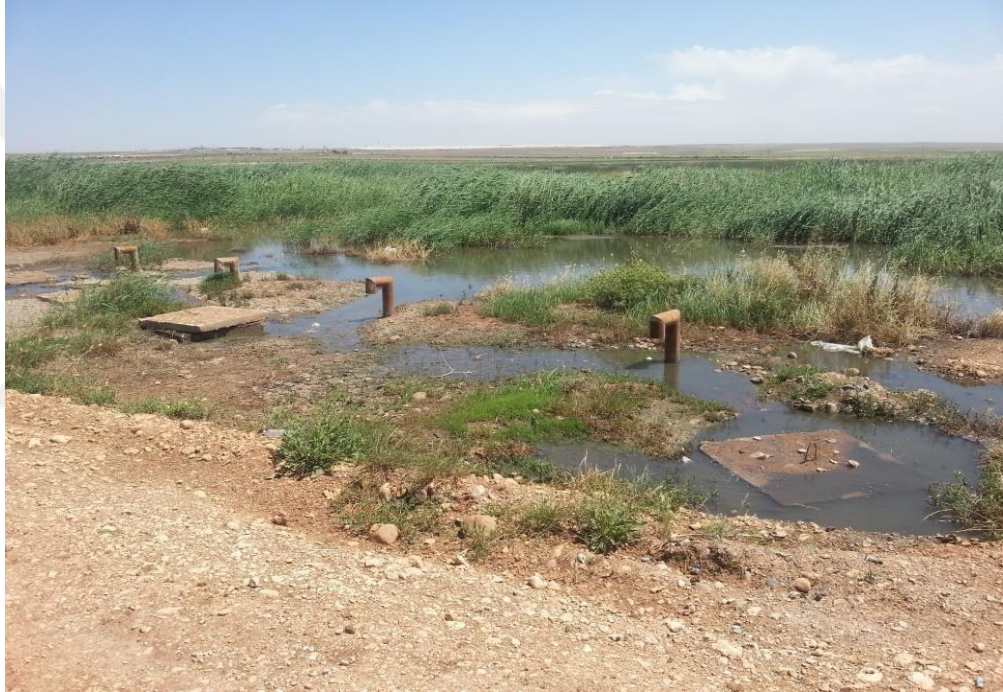
Şekil 4.4. Dolgu malzemesi tıkanmış bir yüzey altı yapay sulak alan sisteminin genel görünümü (OnbirNisan/Şanlıurfa)
