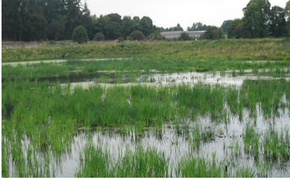
Şekil 1.7. Yüzey altı yatay akışlı yapay sulak alan
