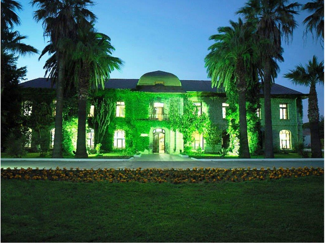
Resim 26. Dalaman TİGEM İdare Binası.
