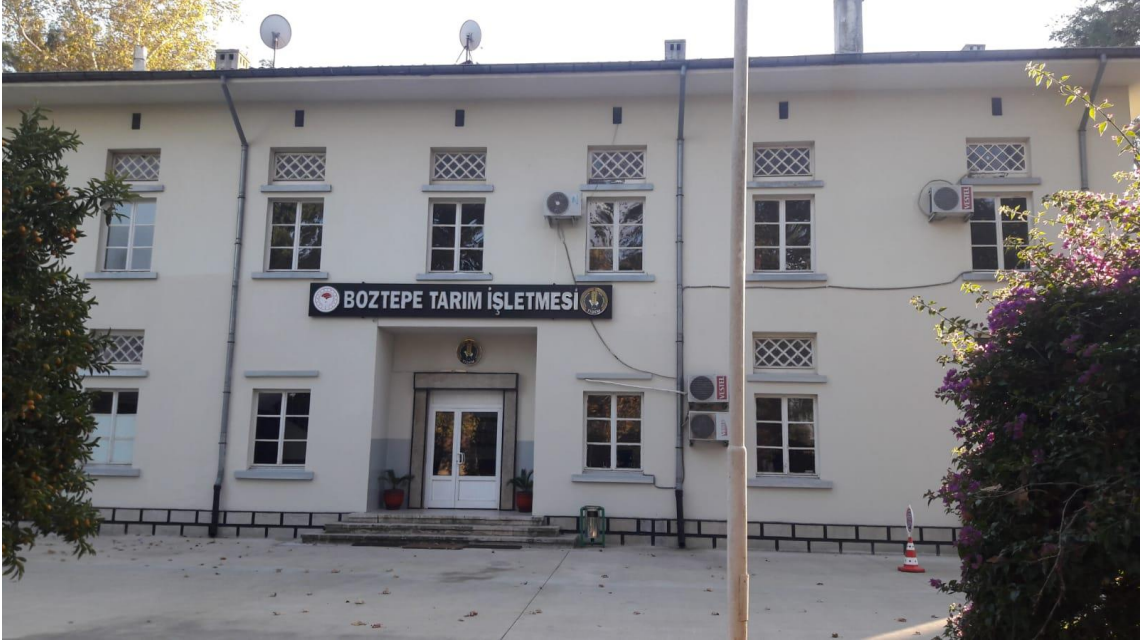
Resim 7. Boztepe TİGEM idare binası.
