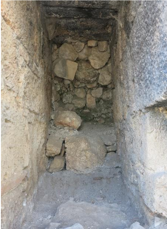
Levha 24c: Meclis Binası Kuzey Kapı İç Dolgu
