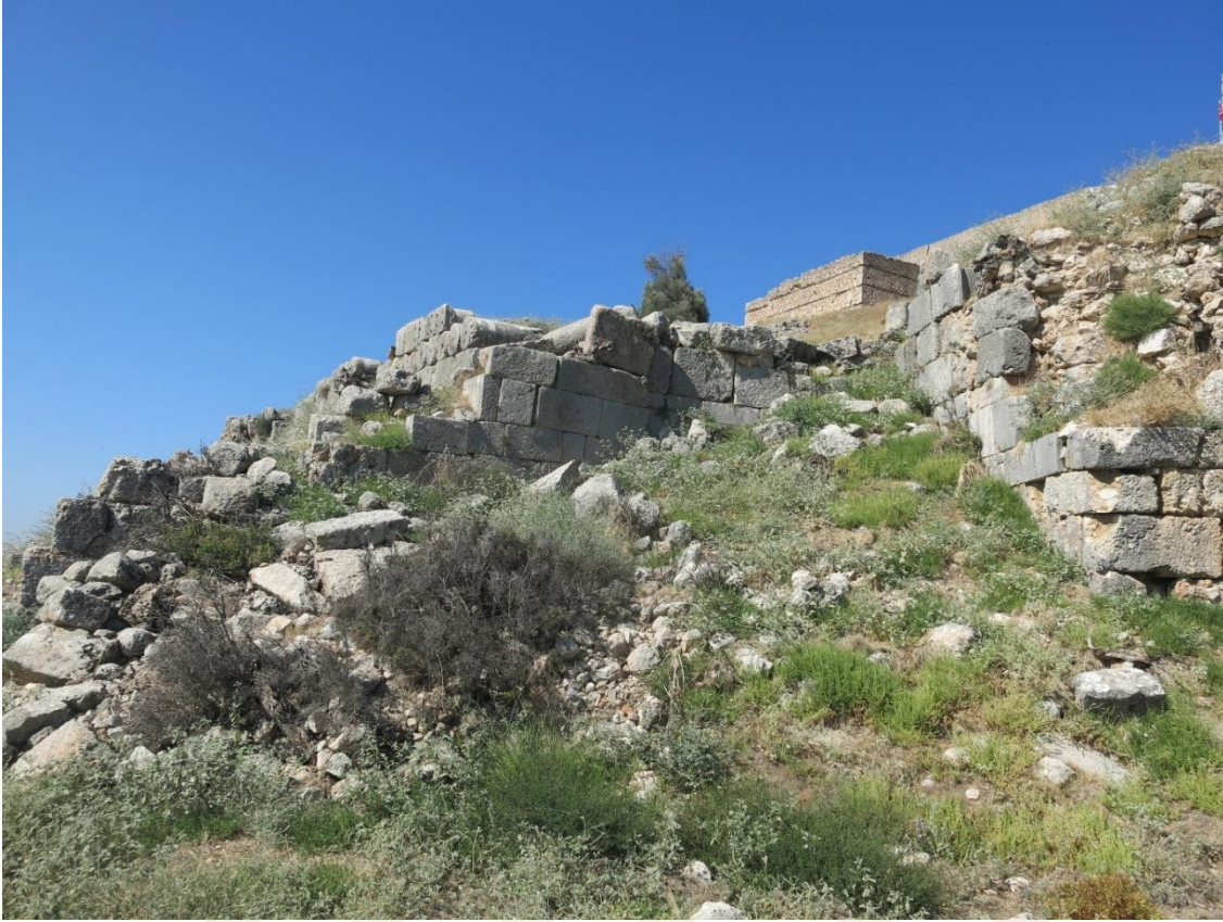
Levha 34a: Akropol Kuzey Yön Surları Kuzeydoğu Köşe
