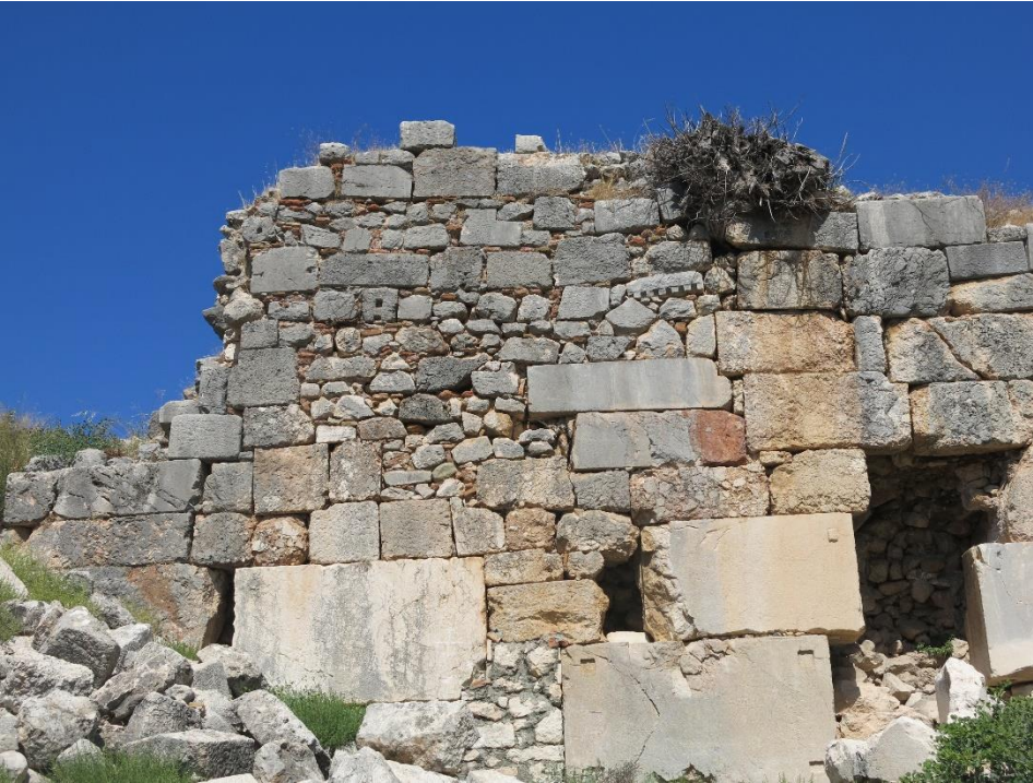
Levha 32b: Burç 1 ve Burç 2 Arasındaki Ortaçağ'a Ait Onarım
