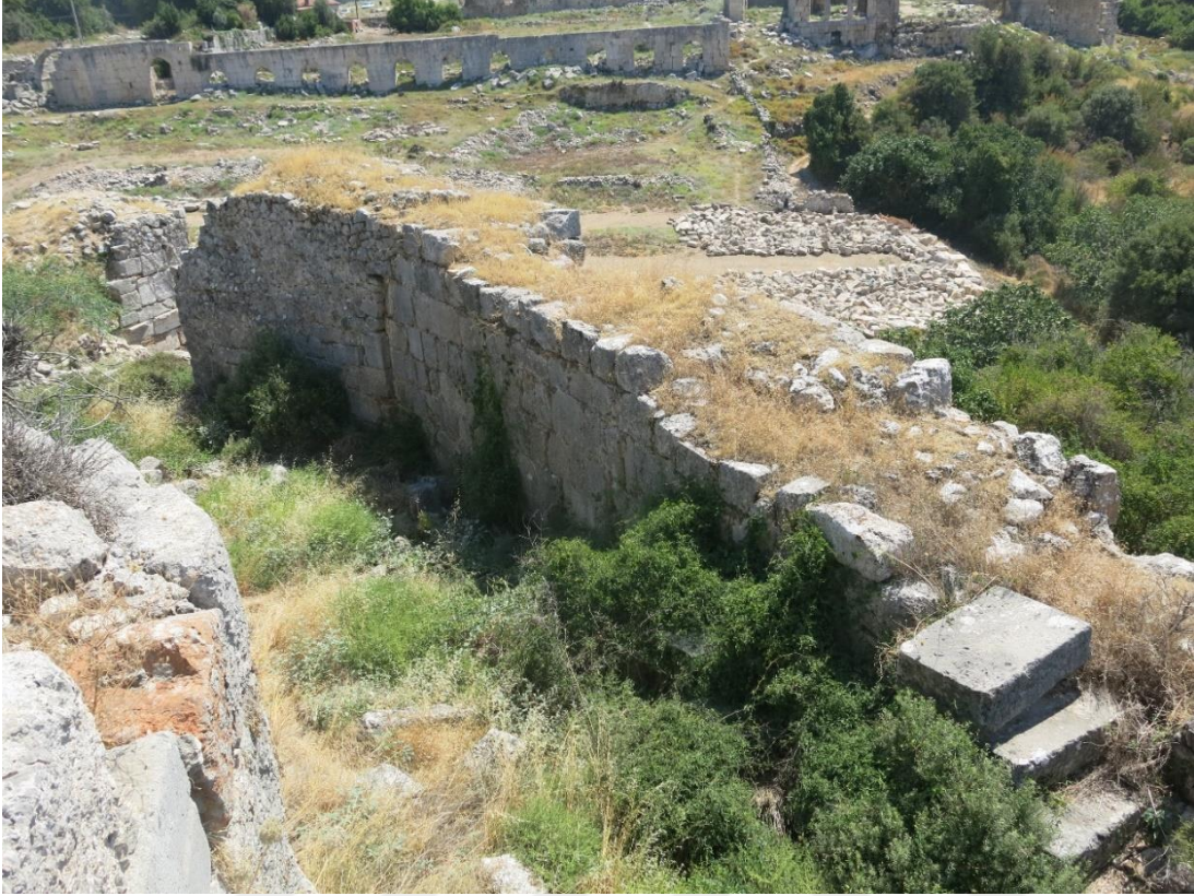
Levha 41a: Akropol Güney Yön Sur Duvarı İç Destek Duvar
