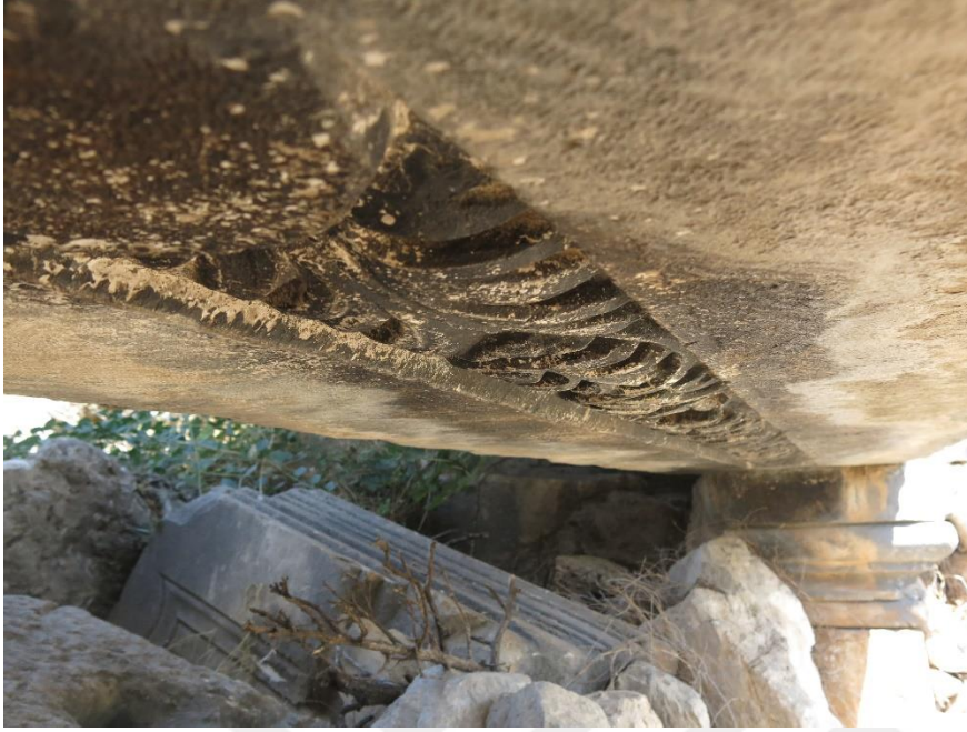
Levha 21a: Akropol Doğu Yön Surları Güney Kapı Lentonun Altındaki Bitkisel Motif
