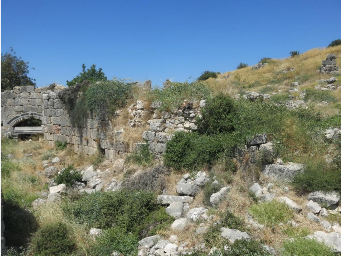
Levha 19b: Akropol Doğu Yön Surları Güney Kapı Giriş Koridoru Kuzey Duvar
