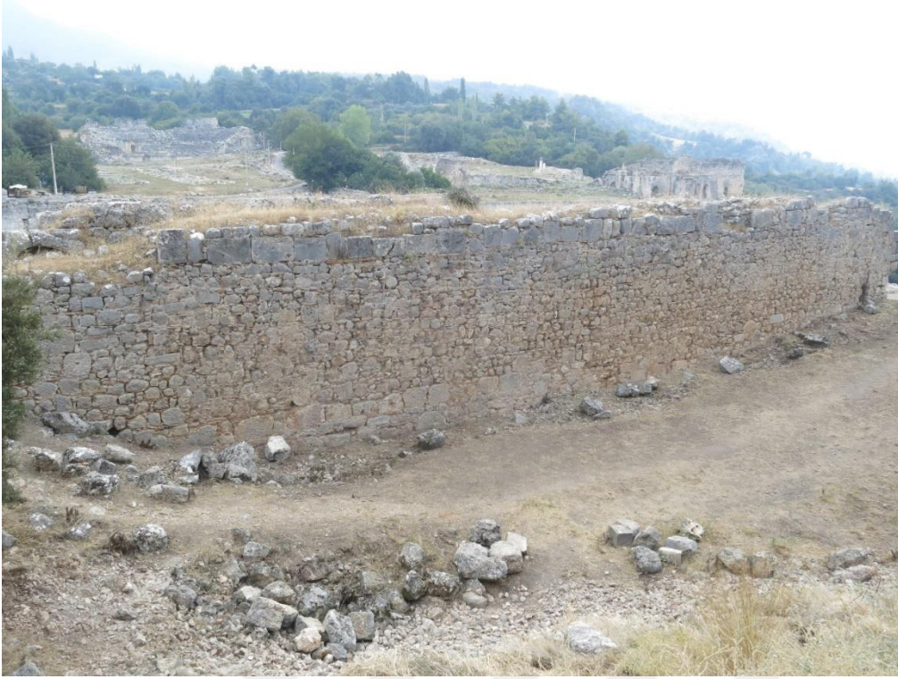
Levha 15a: Meclis Binası Doğu Duvarının arkasına yapılan 2. Evreye Ait Destek Duvarı
