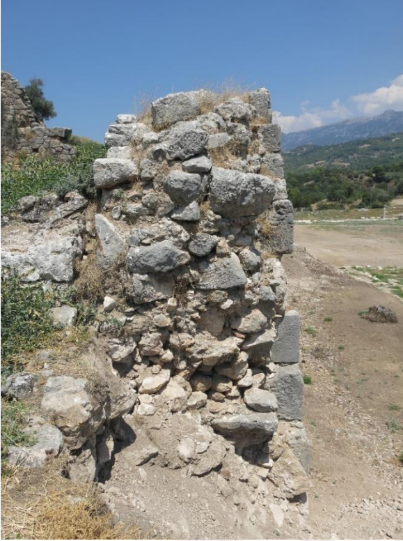
Levha 16a: Akropol Doğu Yön Surları 2. Evre Güneye Uzatılan Sur Duvarı Detay
