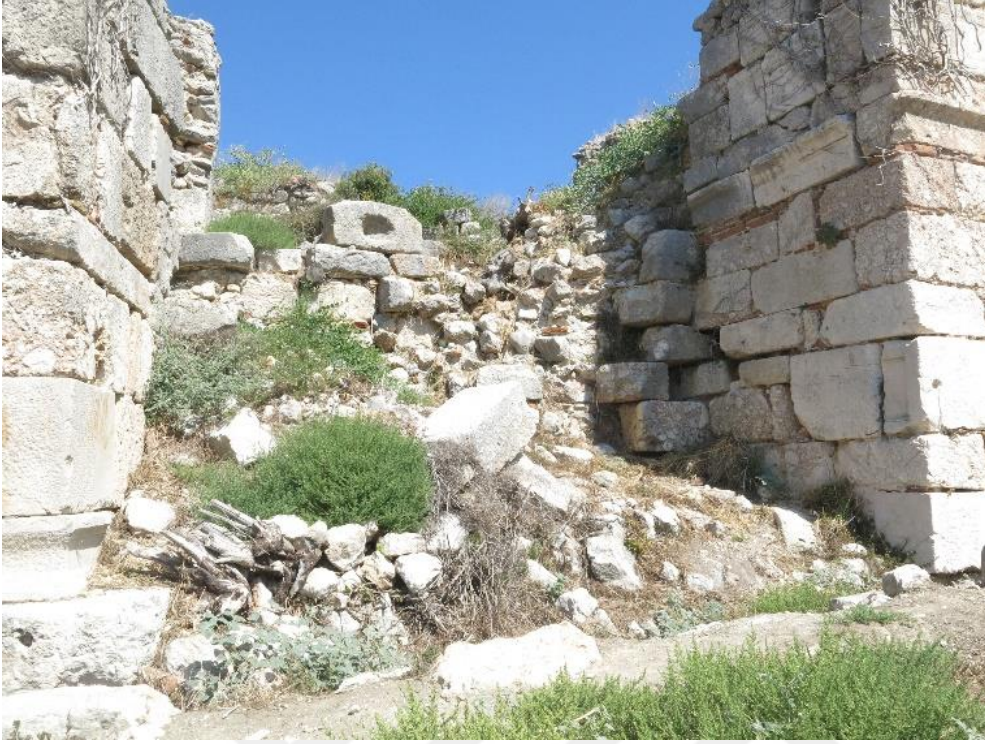
Levha 30a: Burç 2 ve Burç 3 Ara Bağlayıcı Duvar
