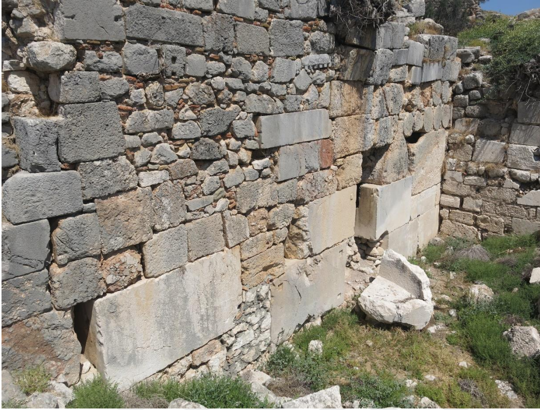
Levha 14a: Akropol Doğu Yön Surları Devşirme Malzeme Lahit Kullanımı
