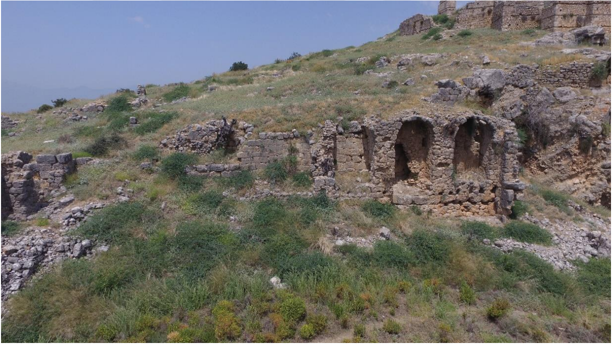
Levha 7b: Meclis Binası Batı İç Duvar
