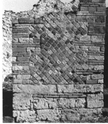
Şekil 3. 40 MS.79 yılındaki patlama sonrası ayakta kalmış olan opus mixtum teknikli duvar örneği Pompeii (Adam,1999)
