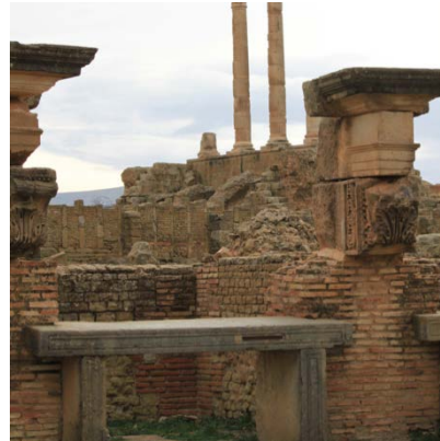
Şekil 5.5 Timgad kütüphanesi opus testaceum tekniği (Pfeiffer, 1931; Tobeytravels,2020)
