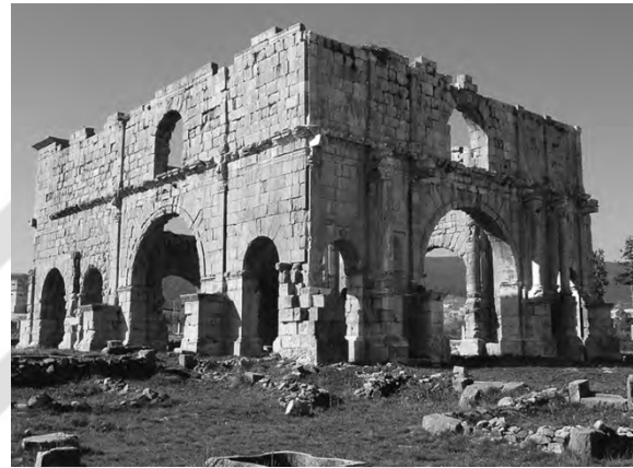
Şekil 5. 4 Praetorium, opus quadratum tekniği (Yegül ve Favro, 2019)
