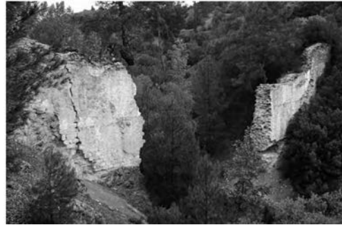
Şekil 4. 74 Denizoluk su kemeri opus vittatum tekniği (Comminto ve Rojas, 2012)
