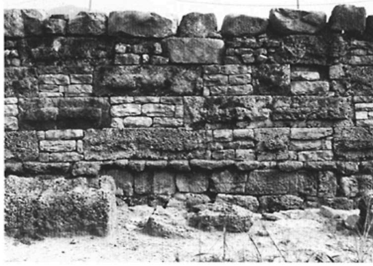
Şekil 3.11 Chequer-work olarak adlandırılan teknik, Velia kenti duvar kalıntısı, M.Ö. 3. yy (Adam, 1991)
