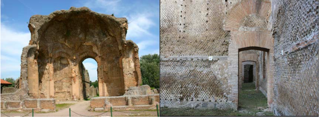
Şekil 3. 28 Hadrianus Villası giriş kısmı opus reticulatum örnekleri, Tivoli, İtalya, MS. 2.yy (Kleiner, 2014)
