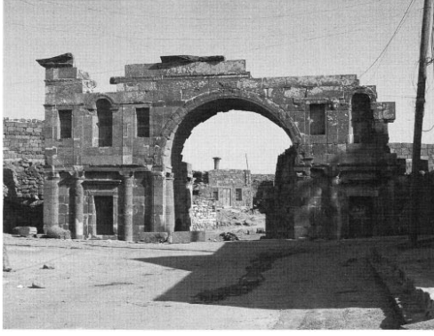
Şekil 5. 19 Tak yapısı opus quadratum tekniği, Bostra (Butcher, 2003)
