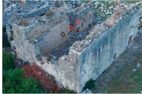
Şekil 4. 187 Patara Nero Hamamı opus emplekton tekniği (Koçak ve Erkoç, 2016)
