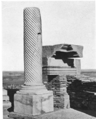
Şekil 5.5 Timgad kütüphanesi opus testaceum tekniği (Pfeiffer, 1931; Tobeytravels,2020)
