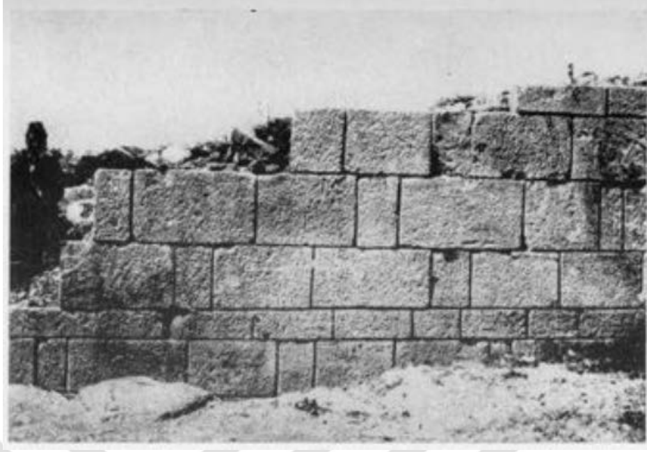
Şekil 3.5 II. Eumenes dönemi şehir duvarı pseudoisodomos görünümü, Pergamon (Lugli,1957)
