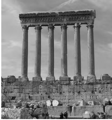
Şekil 5. 16 Baalbek İupiter tapınağı opus quadratum tekniği (Yegül ve Favro, 2019)
