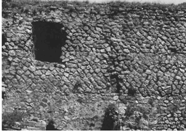
Şekil 3. 24 Pompei Forum Hamamları, opus quasi reticulatum duvar örneği (Adam, 1991)
