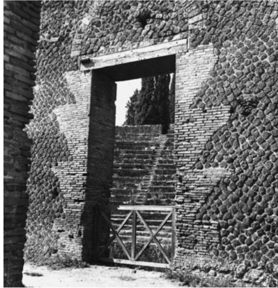
Şekil 3.25 Odeon duvar, opus reticulatum tekniğinin en erken örneklerinden, M.Ö.80, Pompeii (Adam, 1999)
