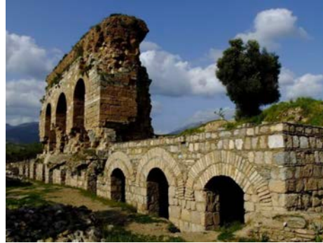
Şekil 4. 77 Tralleis hamam gymnasiumu opus vittatum /Petit appareil, opus testaceum ve opus vittatum mixtum tekniği Tralleis Kazı Arşivi)
