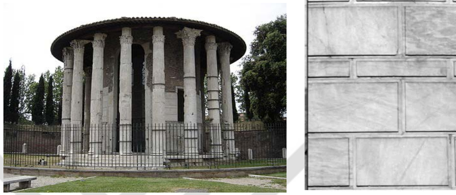
Şekil 2. 44 Victor Herkül tapınağı opus quadratum mermer kaplama, Roma (Ulrich ve Lancaster, 2013)
