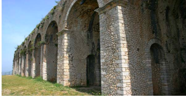
Şekil 3. 18 Jupiter Anxur Tapınağı, opus incertum örneği, M.Ö.90 (Kleiner, 2014)
