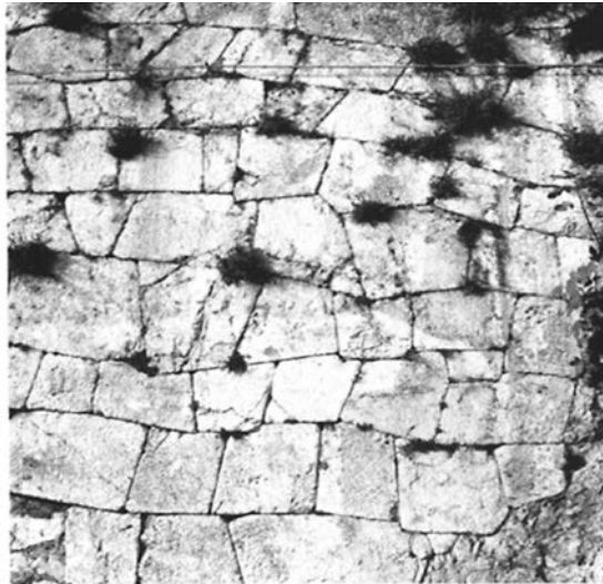
Şekil 3.4 Palestrina Fortuna Tapınağı podyum duvarı, Kiklobik (poligonal)/ opus siliceum duvar örneği M.Ö.240, (Adam, 1991)
