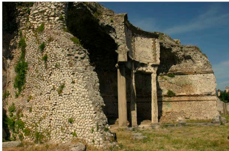
Şekil 3. 19 Fortuna Primigenia Tapınağı teras duvarları, M.Ö.1.yy, opus incertum tekniği, Praenest (Kleiner, 2014)
