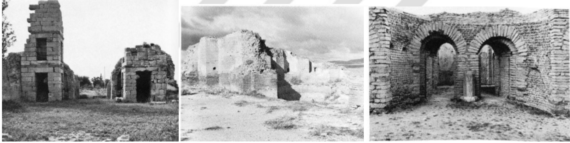
Şekil 5. 9 Lambaesis frigidarium (F), opus quadratum tekniği (sol), Timgad frigidarium (F), opus testaceum tekniği (orta), Djemila caldarium (C), opus vittatum tekniği (sağ) (Yegül, 1992)
