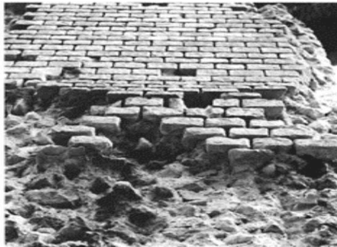
Şekil 3. 31 Metz su kemeri, “petit appareil” tekniği, MS.1.yy, Fransa (Adam, 1999)
