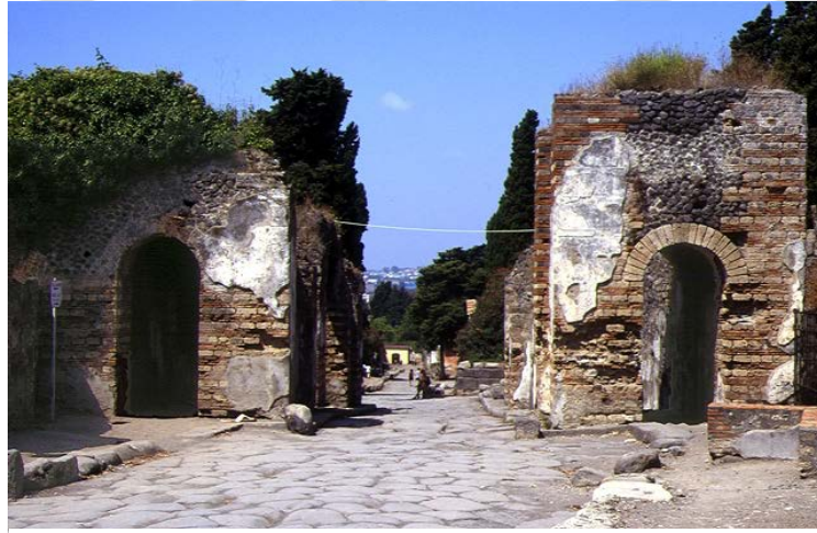
Şekil 3. 38 Herculaneum Kapısı, Pompeii, opus mixtum örneği, M.Ö.80 (Pompeii Interactive, 2020)
