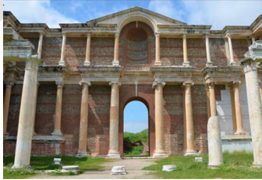
Şekil 4. 85 Mermer kapı opus vittatum mixtum tekniği (Google map, 2020)
