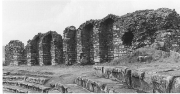
Şekil 4. 73 Aphrodisias Amphitiyatrosu duvarı, “petit appareil” tekniği (Aphrodisias Kazı Arşivi, 2020)
