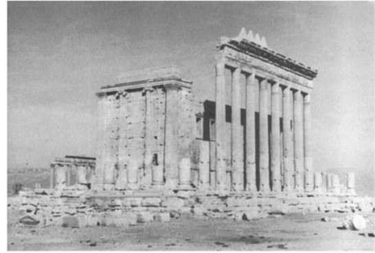
Şekil 5. 17 Palmyra Bel Tapınağı opus quadratum tekniği (Sear, 2006)
