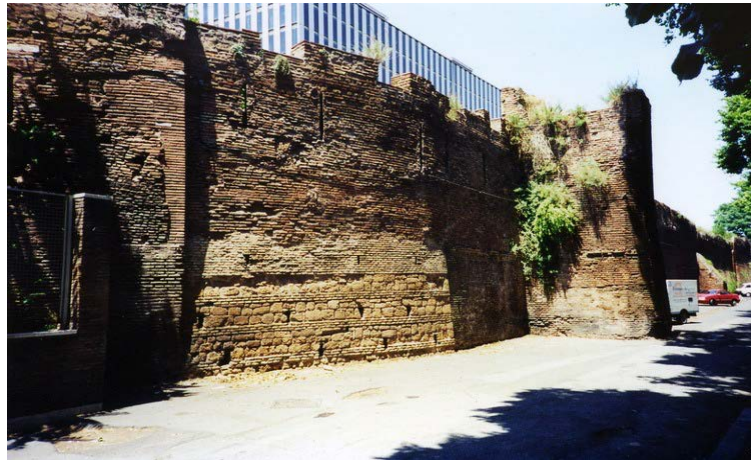
Şekil 3. 34 Praetoria Askeri Kapı, opus testaceum örneği, M.Ö.23 Tiberius dönemi (Cowan, 2016)
