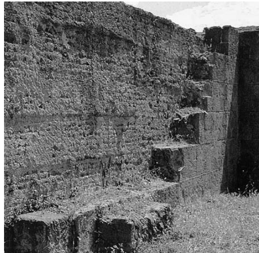
Şekil 2. 37 Roma betonu kalıntısı ve opus quadratum tekniği ile yüzlenmiş hali Antoninus ve Faustina Tapınağı MS.190 (Wright,2005)
