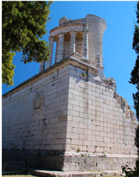
Şekil 3. 32 Augustus Anıtı, “Petit Appareil” tekniği, La Turbie, M.Ö.5 (Kleiner, 2015)
