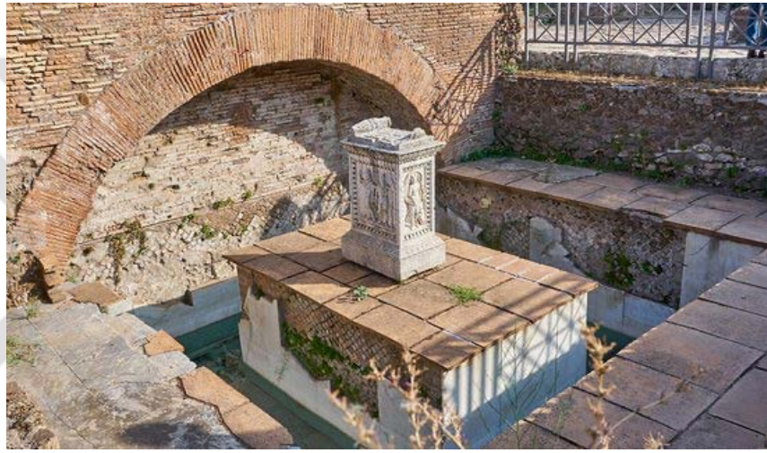
Şekil 3. 23 Lacus Juturnae opus quasi reticulatum duvar örneği, Forum Romanum, M.Ö.116 (Scullard, 1981)
