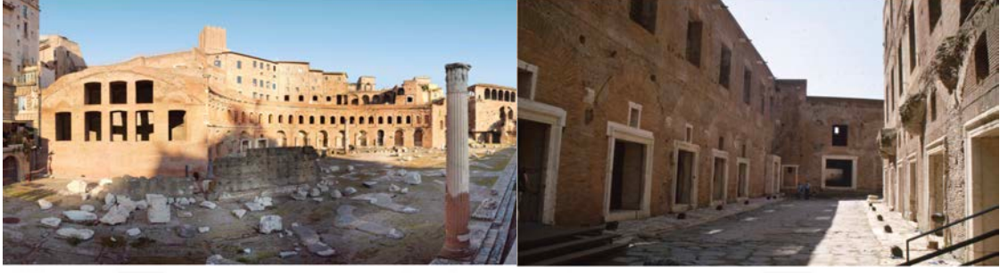
Şekil 3. 36 Trajan marketi, opus testaceum örneği, M.S.2.yy, (Tuck, 2015)
