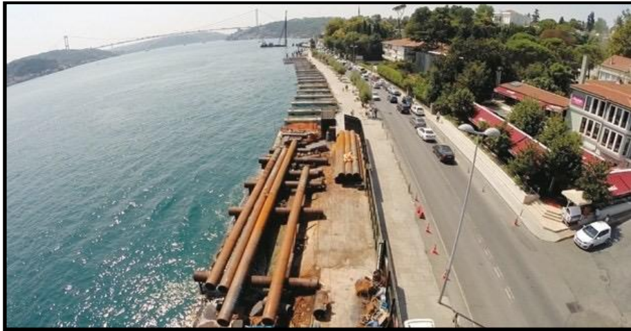
Şekil 3.101 : Emirgan sahil yolu yapım aşaması (URL-53)
