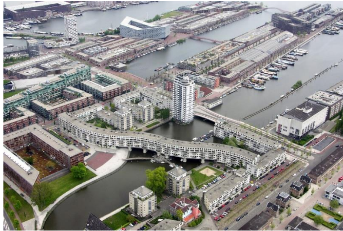
Şekil 2.33 : Batı Amsterdam projesi genel görünüm (URL 22).
