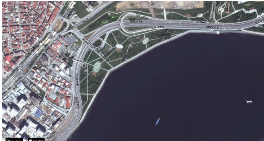
Şekil 4.34 : Ataport Proje alanının mevcut hali
