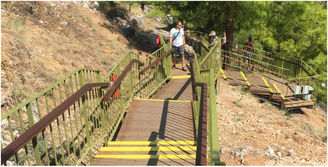
Şekil 4. 50 Alanya Kalesi'nde Ehmedek Kalesi ile teleferik istasyonu arasındaki yürüyüş yollarında kullanılan korkuluklar (Fotoğraf: Ş. Bora, 2019)
