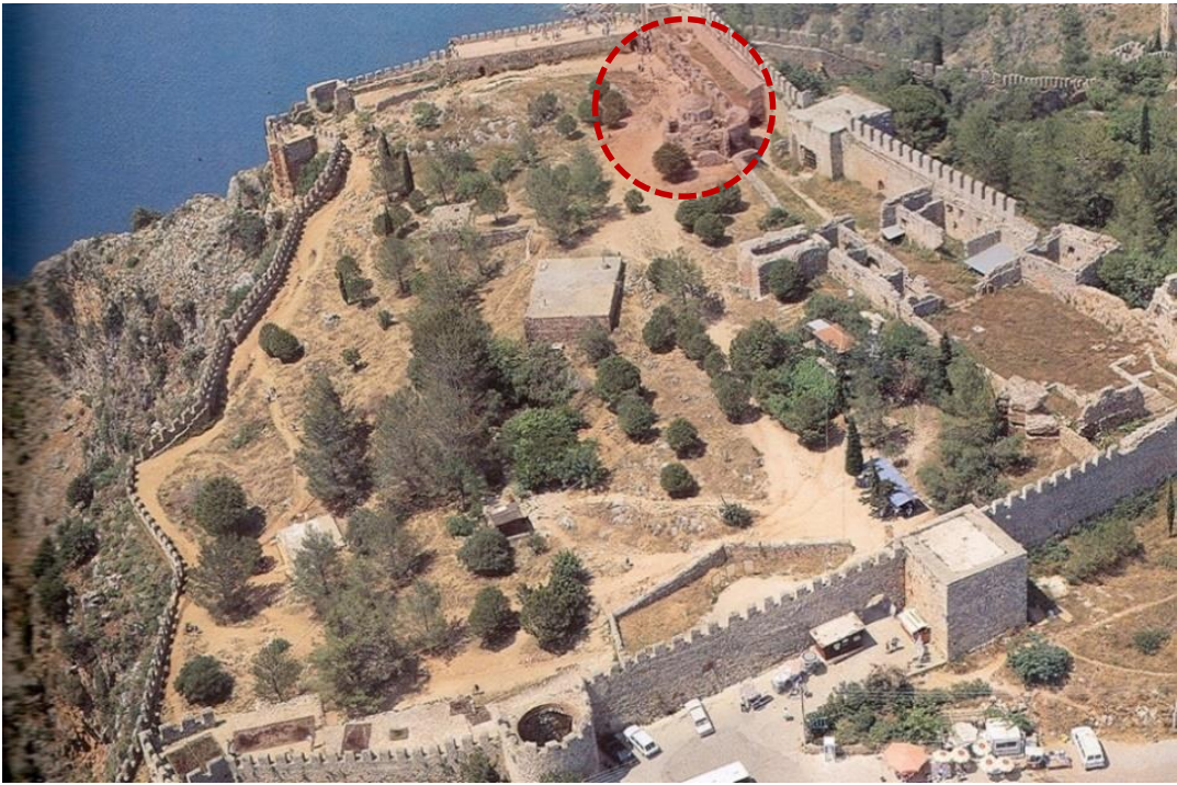
Şekil 2. 23 İç kale'nin genel yapısı ve Bizans Kilisesi [31]
