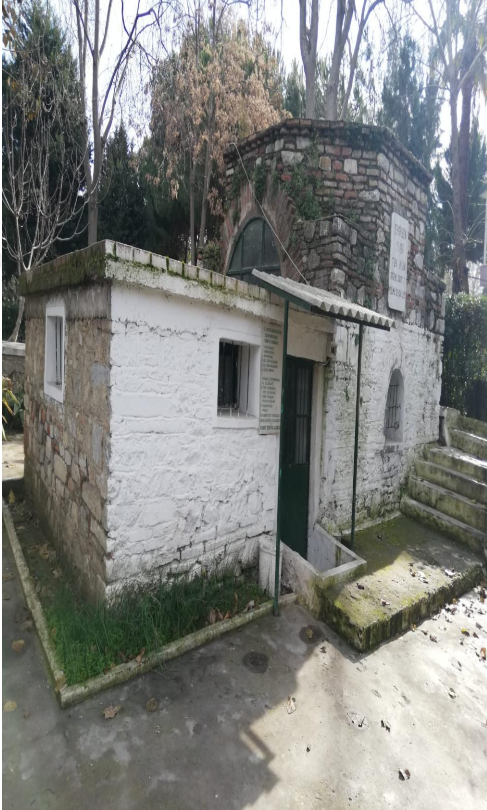
Ek 4: Şihâbüddîn Sivâsî'nin türbesinin dış görünümü
