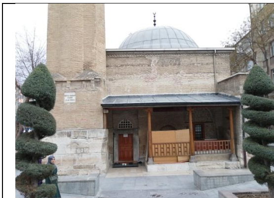
Şekil 4.4. Hoca Hasan Mescidi kuzey cephesi
