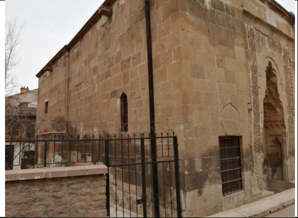
Şekil 4.22. Taş Mescit güneybatı cephesi
