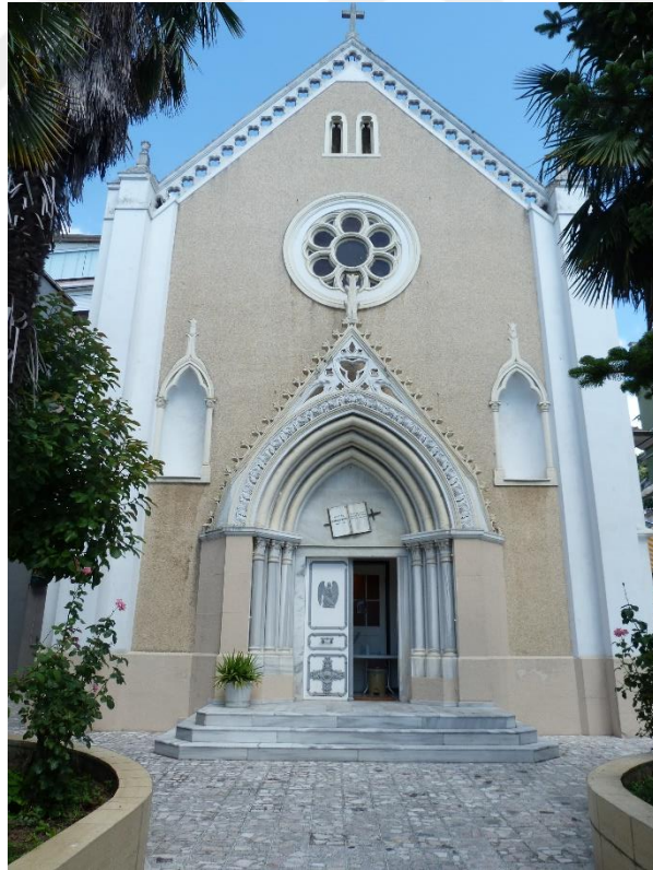
Şekil D.36 : Güneydoğu cephesinde niteliksiz mozaik sıva.
