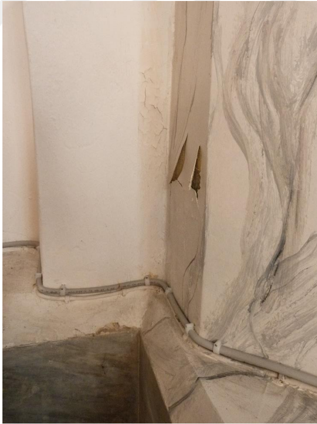
Şekil D.14 : Plastırlar üzerinde sıva ve boya kaybı.
