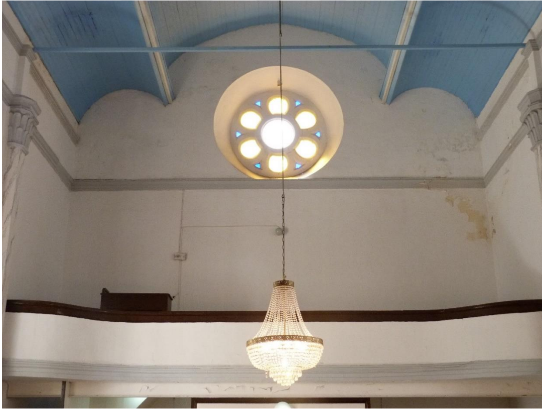
Şekil D.22 : Naos boyalı duvarlarında renk değişimi ve lekelenmeler.
