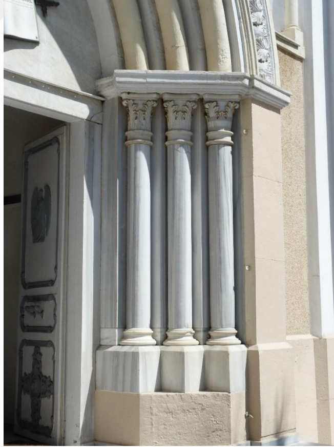
Şekil C.91 : Güneydoğu cephesinde bulunan mermer sütunçeler.
