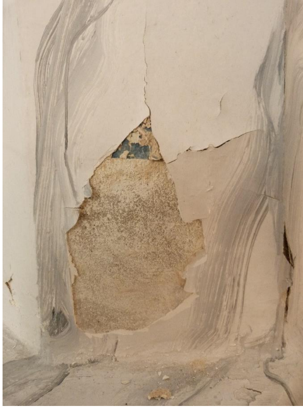
Şekil D.34 : Plastırlar üzerindeki niteliksiz boya ve malzeme kaybı.
