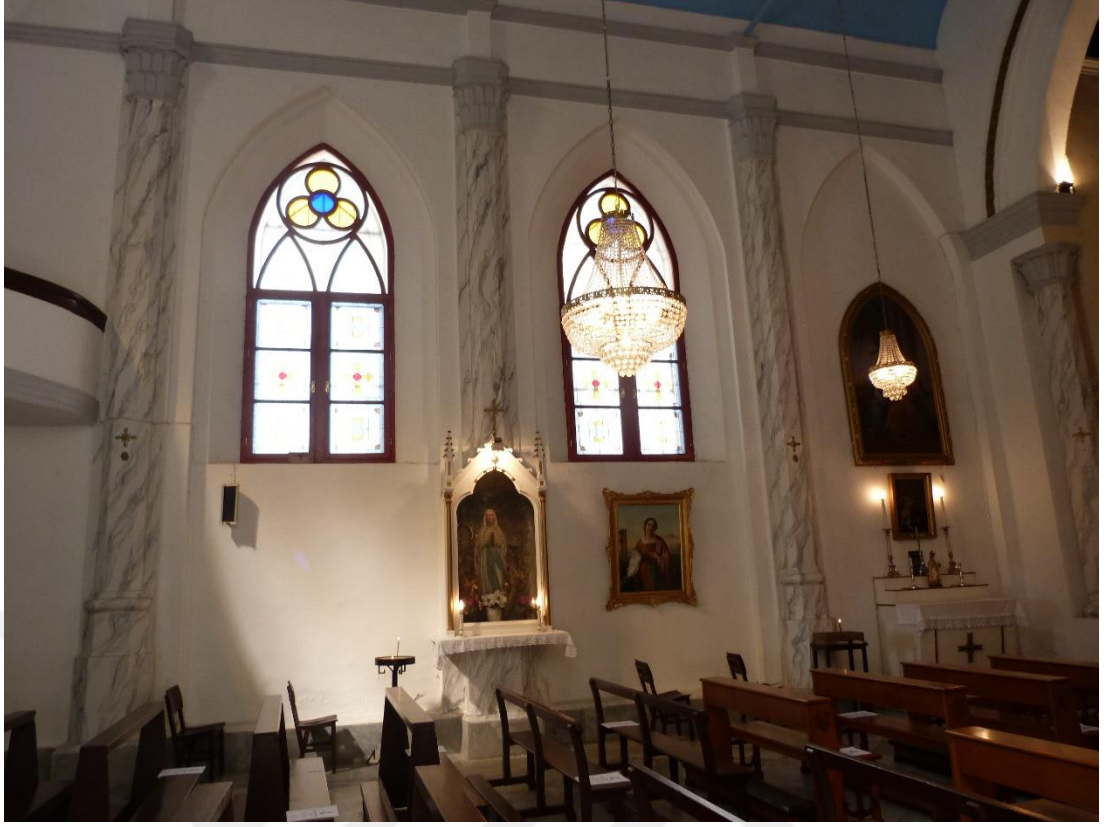
Şekil C.9 : Naosun güneybatı duvarında bulunan plastırlar.
