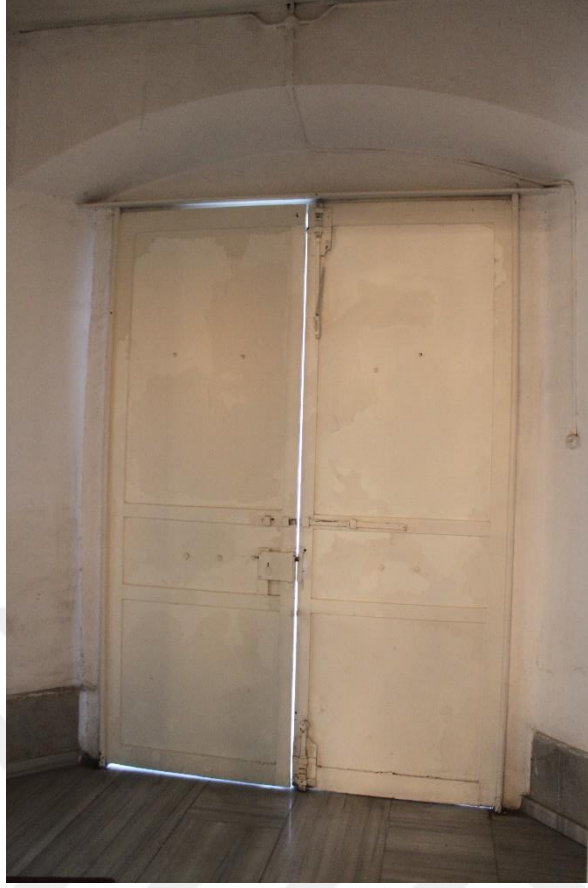
Şekil C.3 : K01 kapısı üzerindeki basık kemer.
