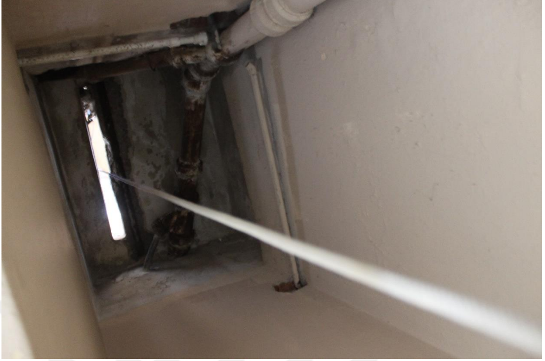
Şekil C.44 : ZK 08 mahallinde bulunan çanın çalınmasını sağlayan halat.
