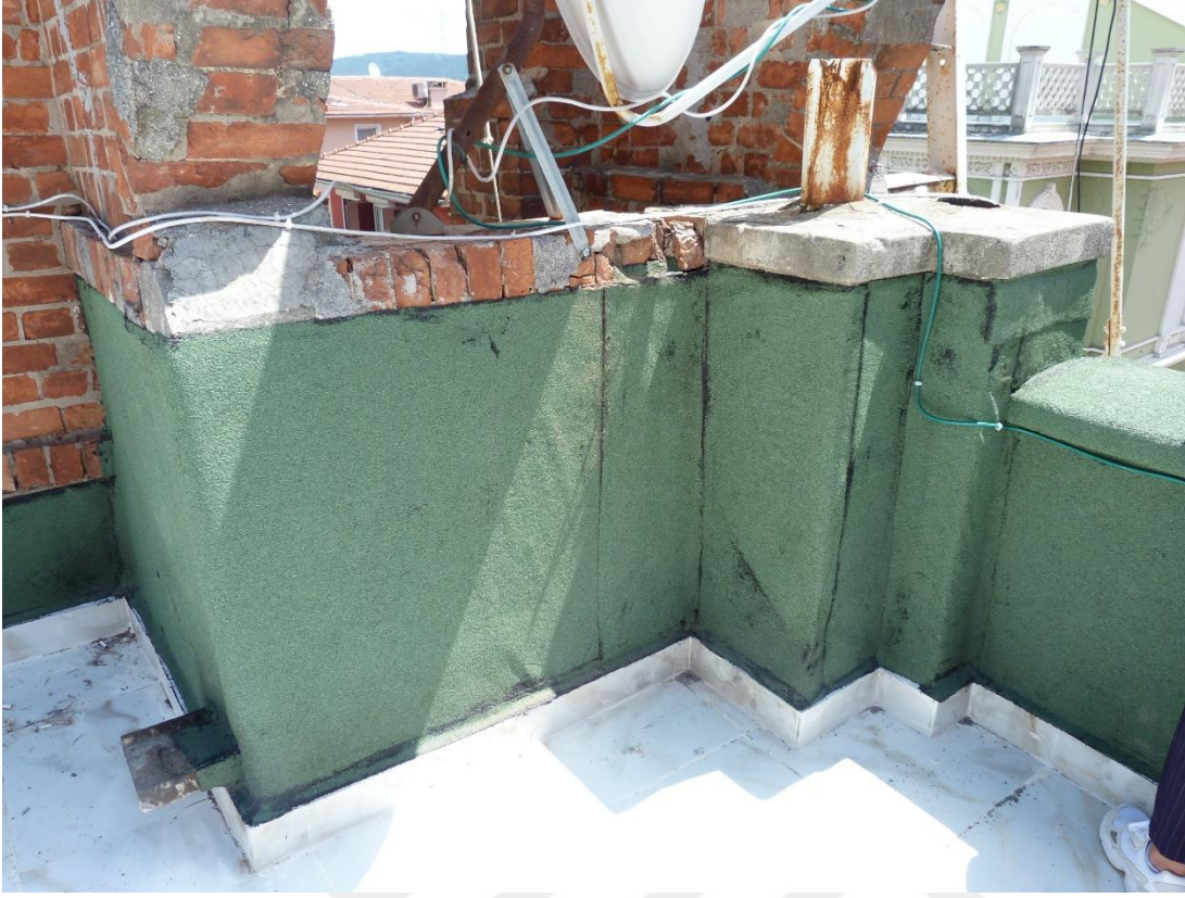
Şekil D.13 : Çan kulesinde malzeme kaybı.
