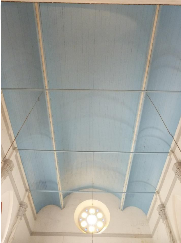
Şekil C.87 : Naos mahallinin ahşap örtüsü.
