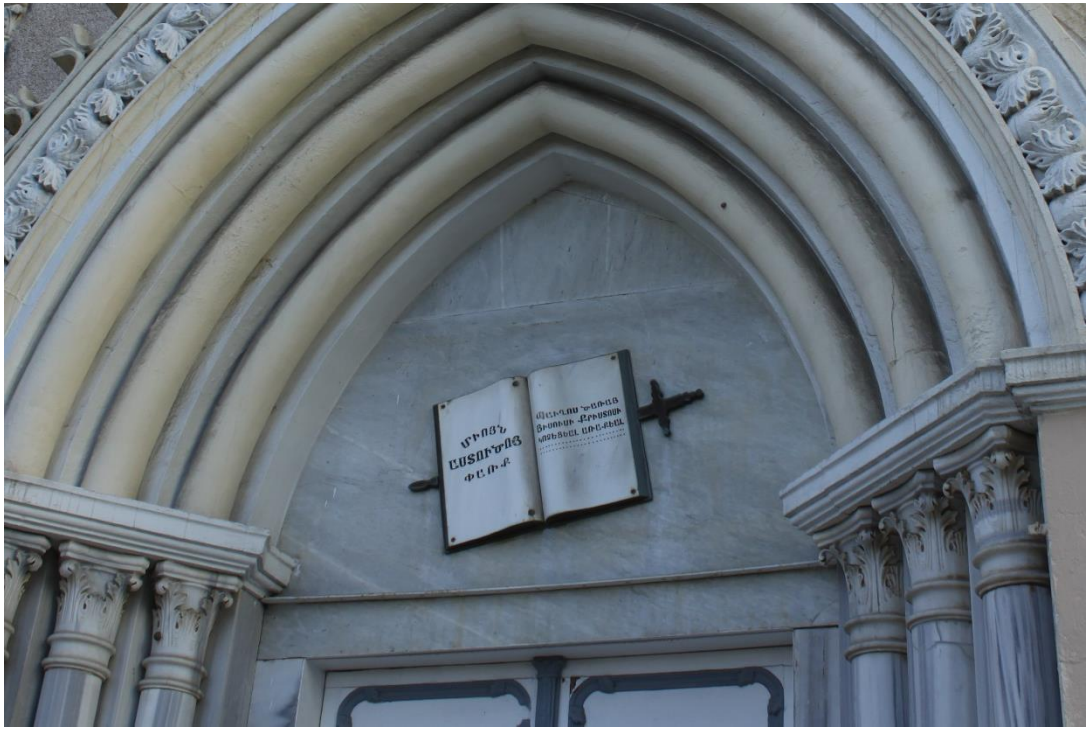
Şekil C.65 : Güneydoğu cephesinde bulunan kitabe.
