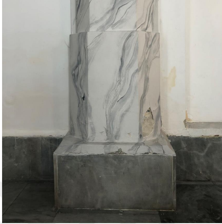
Şekil C.92 : Kaide ve süpürgeliklerde kullanılan mermer kaplama.
