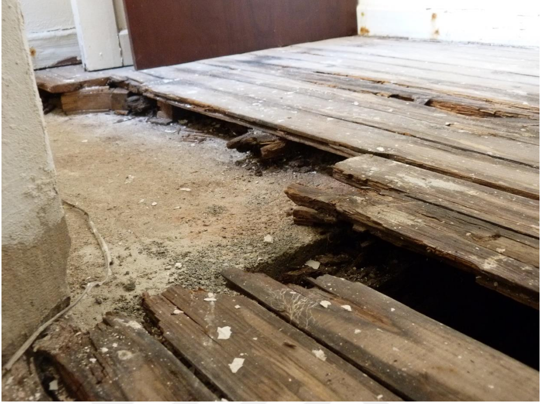
Şekil C.84 : K 104 Oda 1 de görünen döşeme katmanları.
