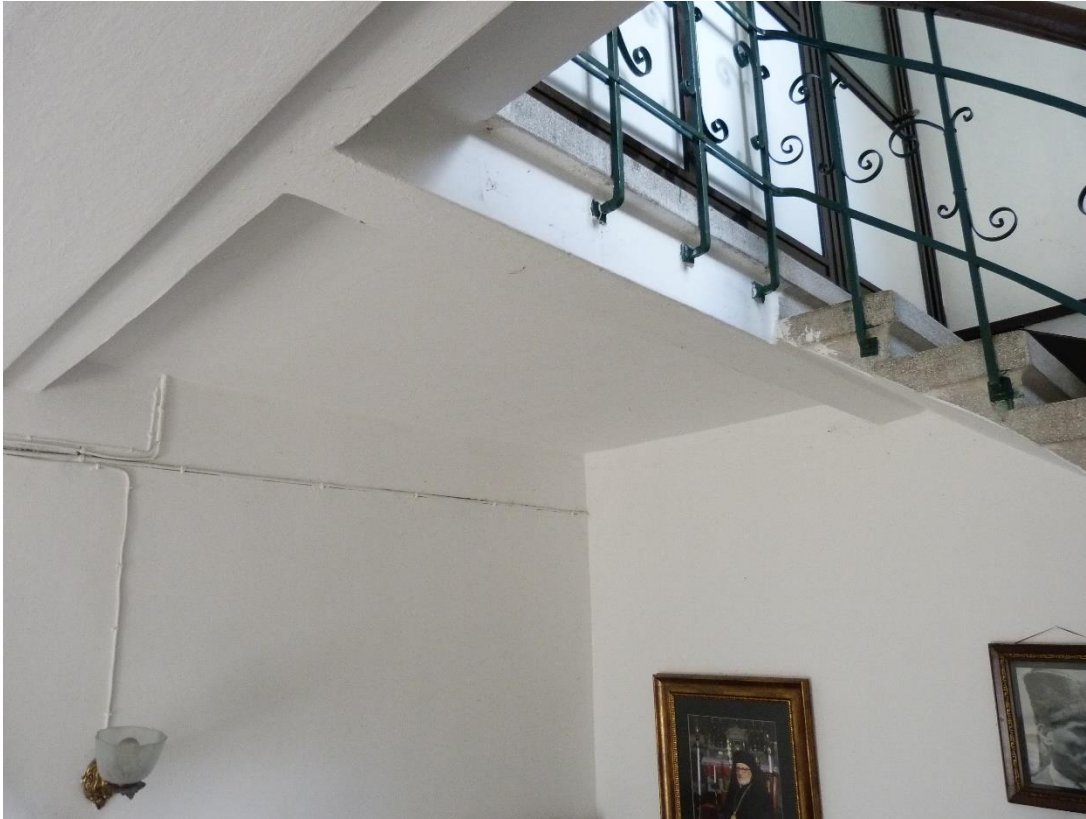
Şekil C.35 : ZK 05 Betonarme kirişler.
