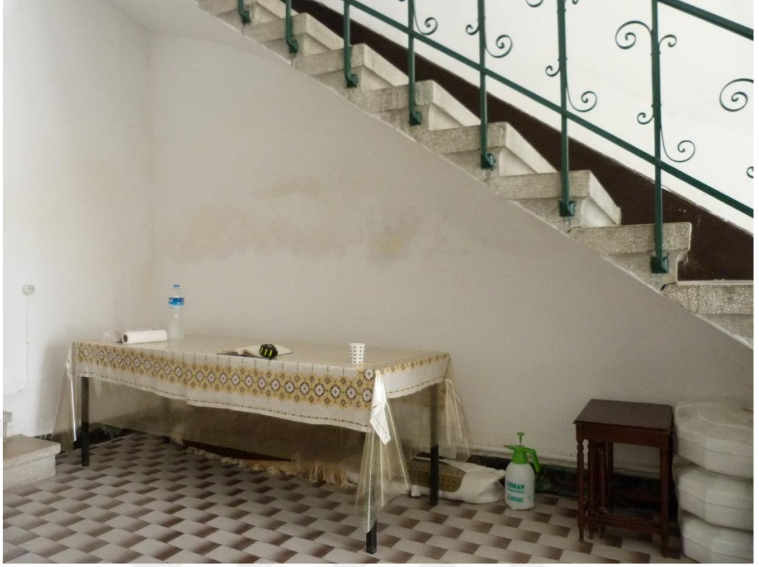
Şekil D.23 : Hol-1 duvarında neme bağlı renk değişimleri.
