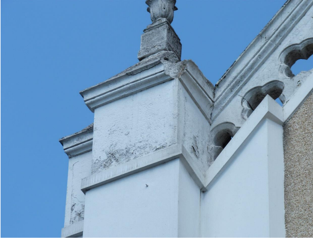
Şekil D.10 : Kule kaidesinde kavlanma.
