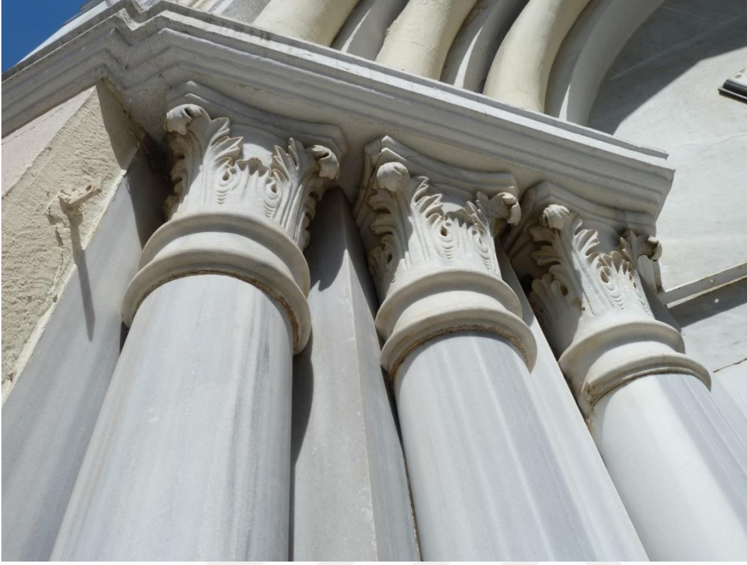
Şekil D.17 : Sütunçe başlıkları ile gövde birleşiminde malzeme kaybı.
