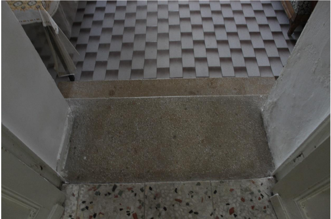
Şekil C.97 : Hol-2'ye geçişi sağlayan mozaik merdiven.
