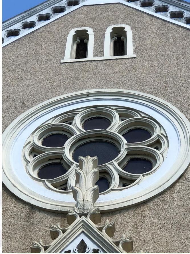
Şekil C.100 : Güneydoğu cephesinde bulunan alçı gül pencere.
