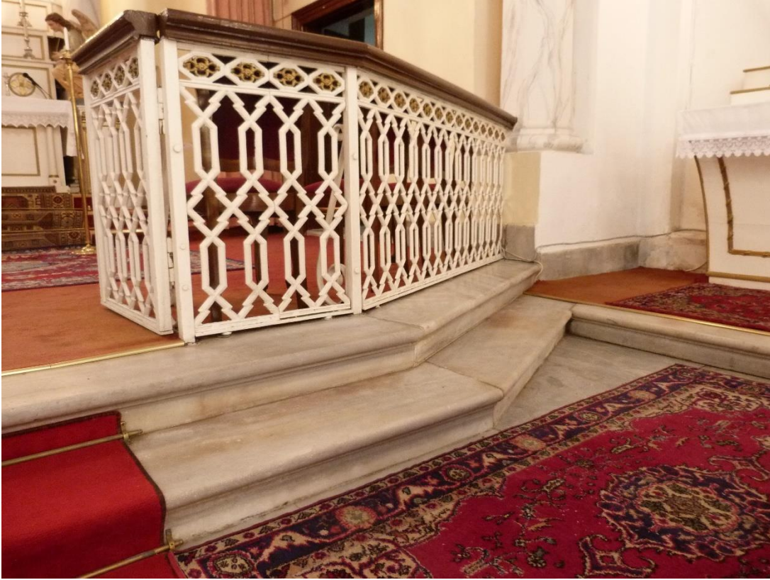
Şekil C.22 : Dökme demir korkuluk.
