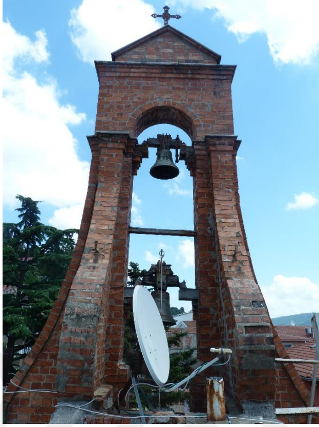
Şekil D.11 : Çan kulesinde çimento esaslı harç kullanımı.
