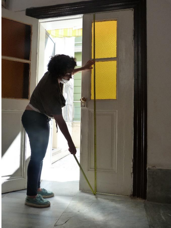
Şekil D.18 : Naos mermer döşeme kaplamasında çatlaklar.
