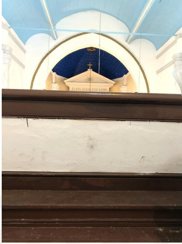
Şekil C.32 : Koro katı ahşap platform ve küpeştesi.
