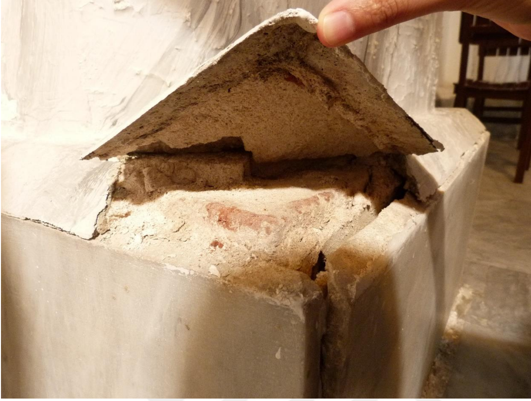
Şekil D.33 : PL2 plastırı kaidesi malzemesinde koparak ayrılma.
