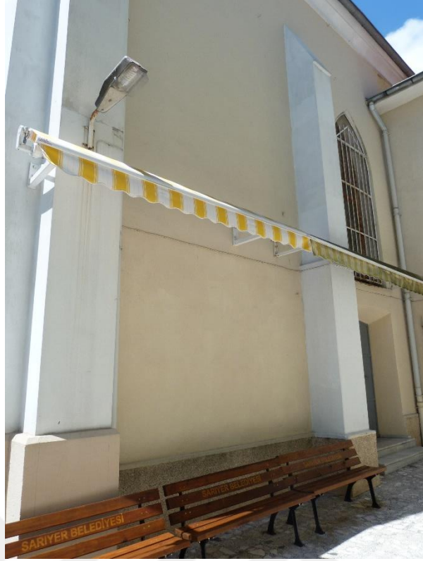
Şekil D.39 : Kuzeydoğu cephesine sabitlenmiş tente ve aydınlatma elemanı.
