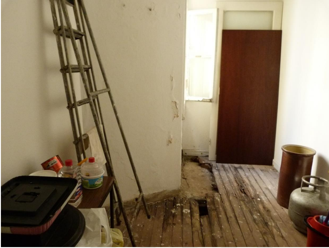
Şekil D.5 : K104 Oda 1 Ahşap kaplama ve kirişlerde çürüme.
