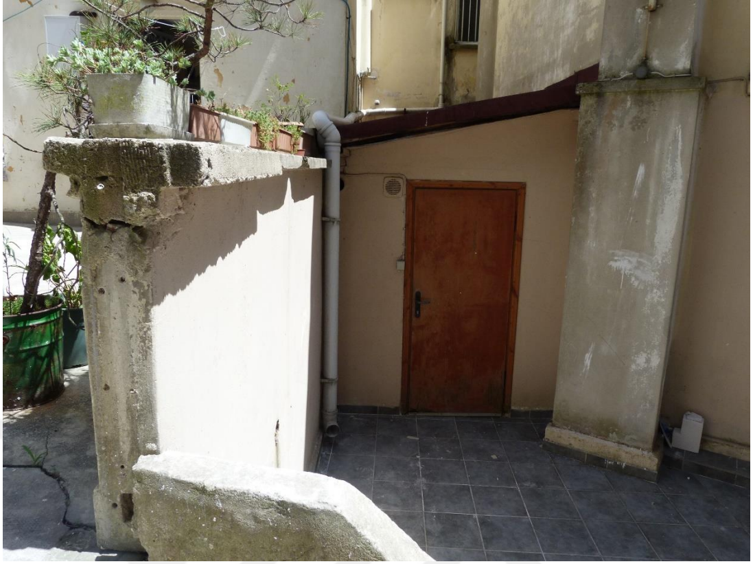
Şekil C.72 : Güneybatı cephesi mutfak girişi.
