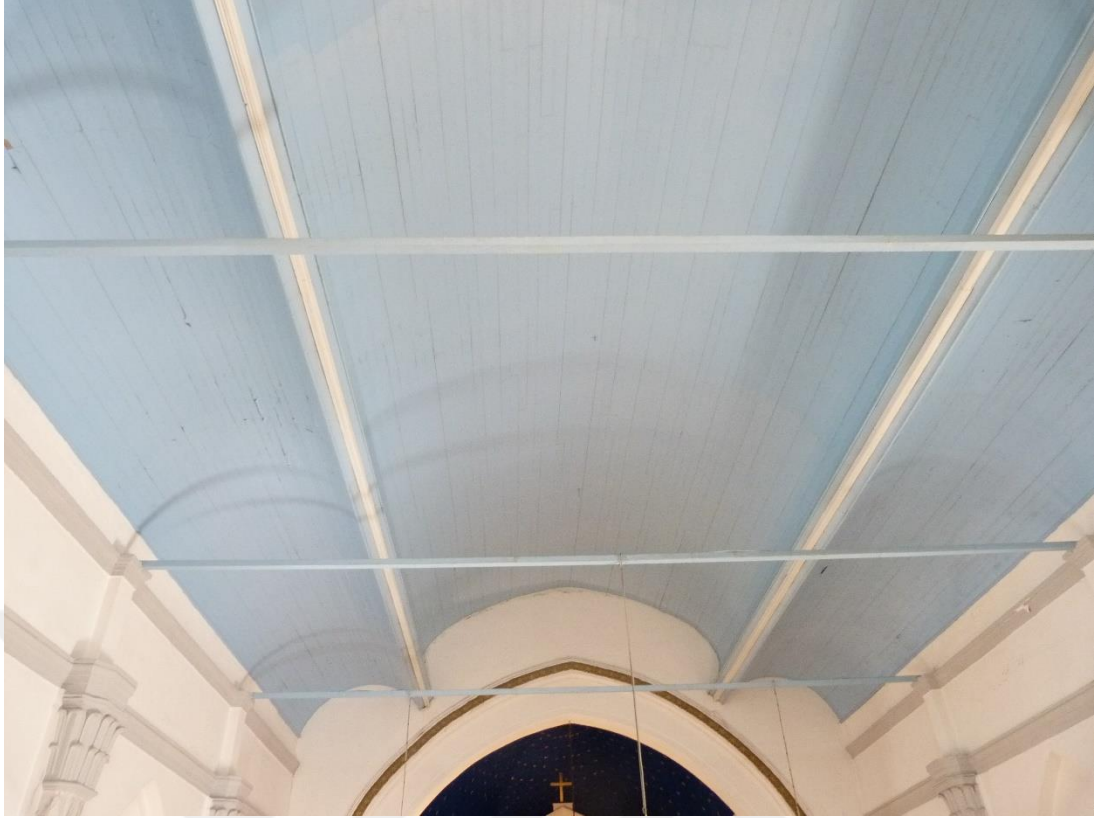
Şekil C.20 : Plastırlar arasında bulunan gergiler.
