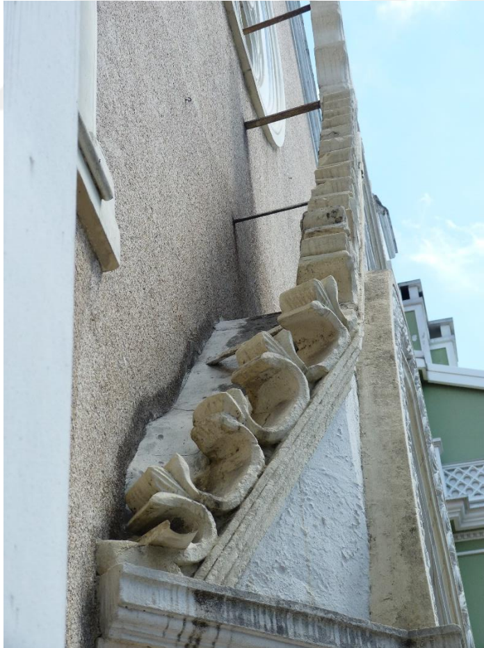
Şekil C.95 : Strüktürel destek amaçlı kullanılan metal elemanlar.
