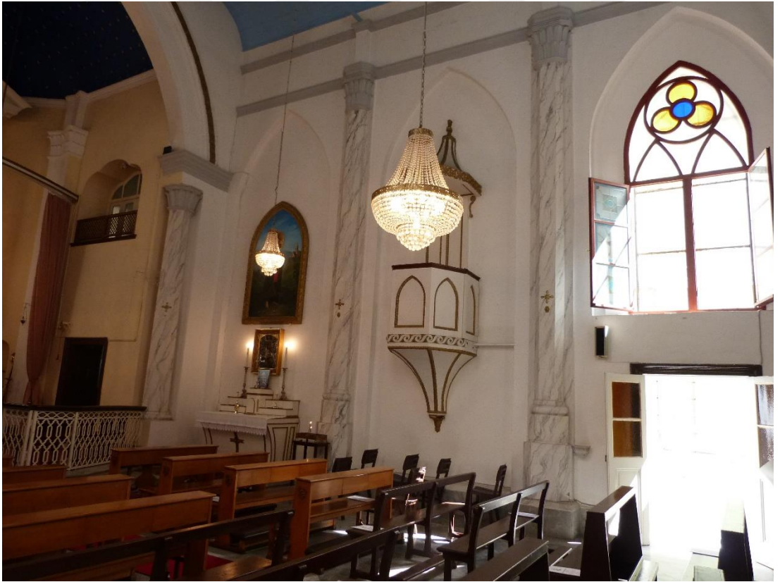
Şekil C.9 : Naosun güneybatı duvarında bulunan plastırlar.
