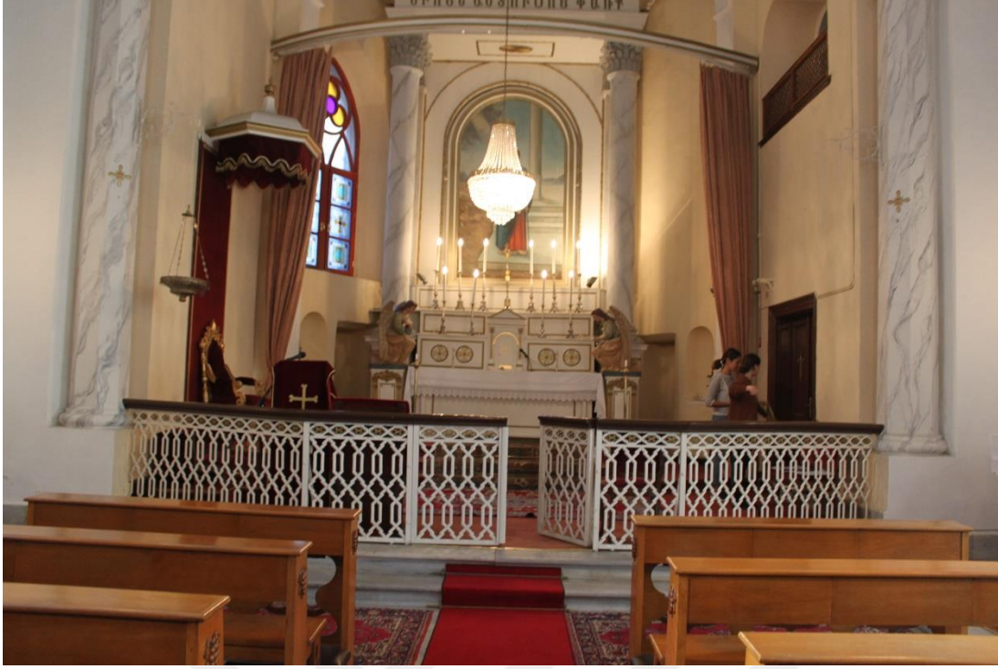
Şekil C.94 : Apsiste bulunan ahşap küpeşteli demir korkuluk.
