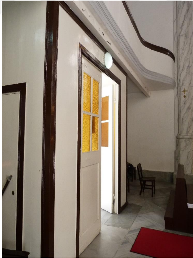
Şekil C.77 : ZK 01 Rüzgarlık mahallinin ahşap duvarları.
