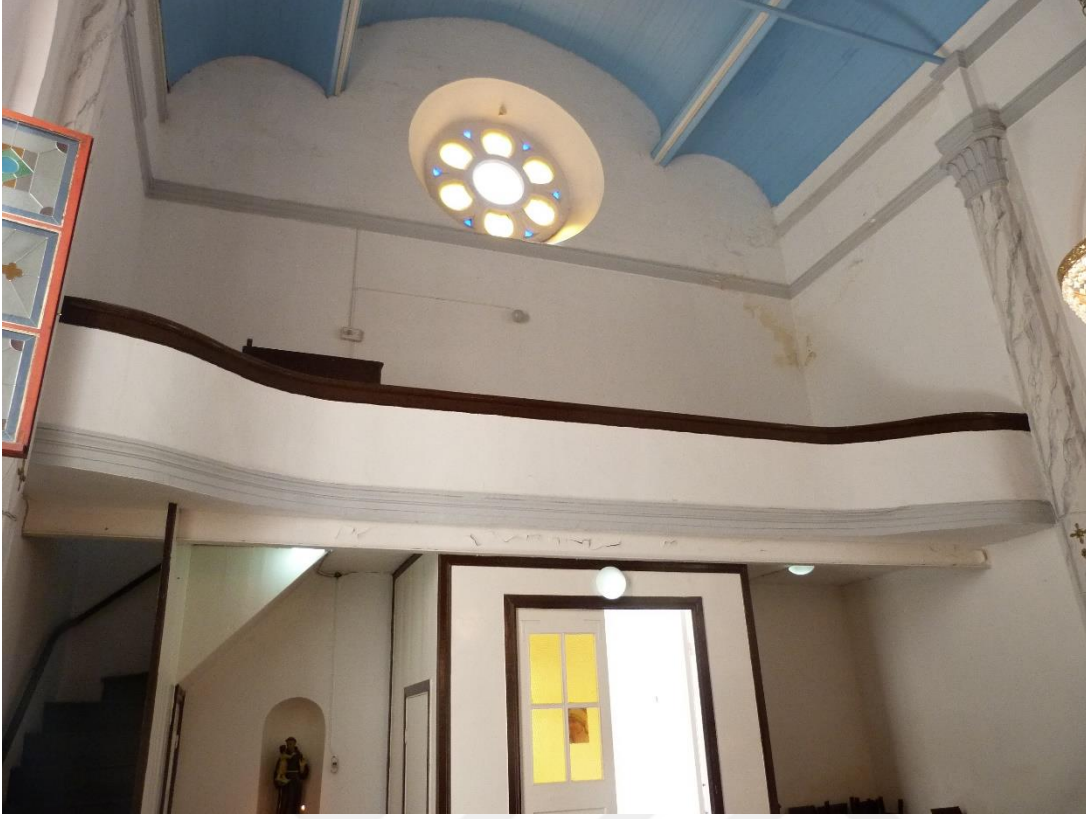
Şekil C.82 : Koro katını destekleyen I putrel.
