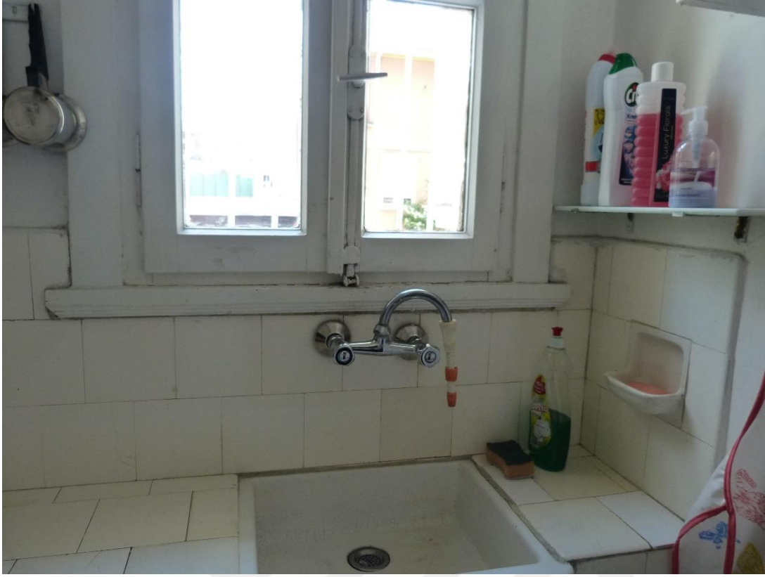
Şekil C.102 : P11 kodlu ispanyolet kilitli pencere.
