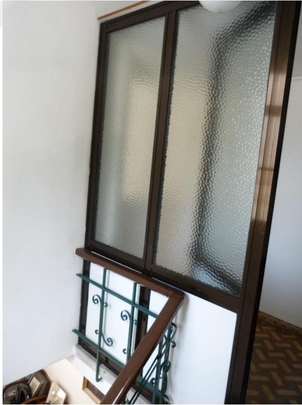
Şekil D.38 : Hol-5 mekanını sınırlayan niteliksiz alüminyum doğrama.
