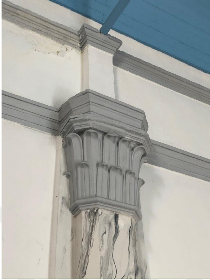
Şekil C.98 : Alçı başlık ve silmeler.
