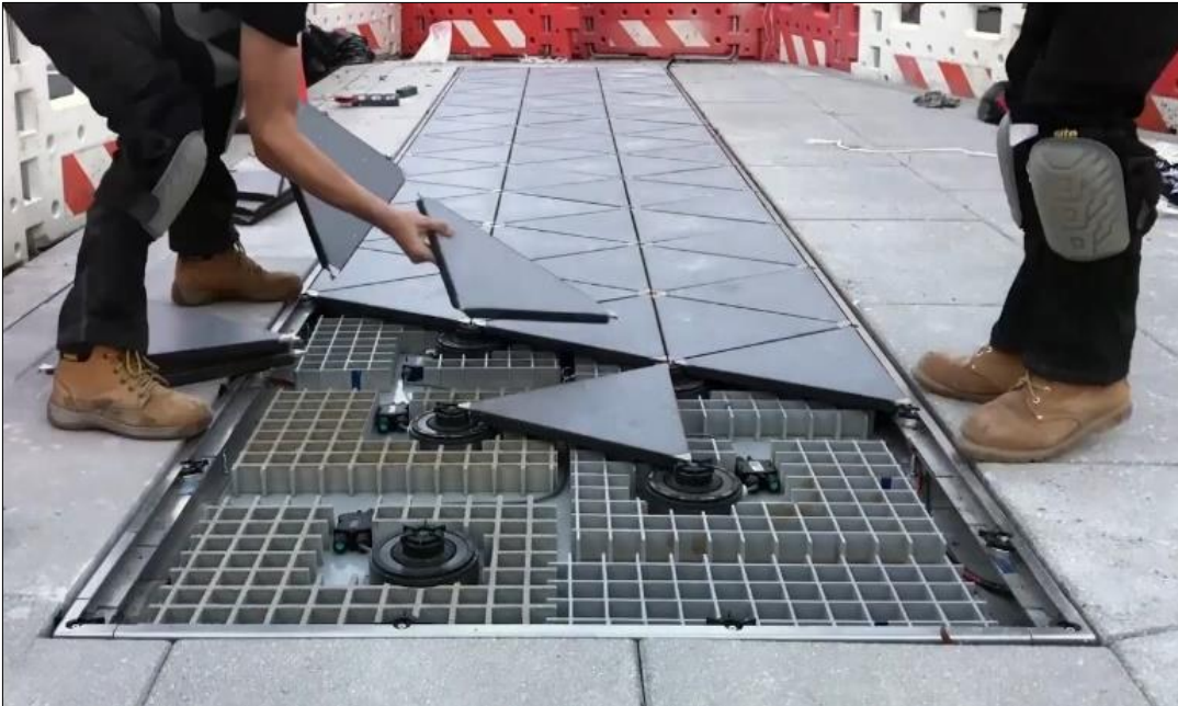
Şekil 48. Enerji üreten zemin döşemeleri uygulama aşaması
