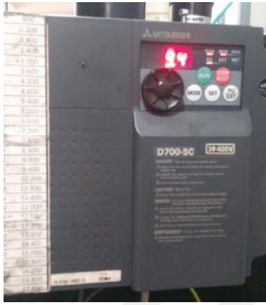
Resim 6. 6. Test kontrol paneli
