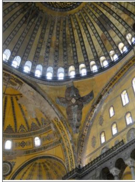
Şekil 3.27: Ayasofya İç Mekânında Pendentifin Görünümü (K: Ahunbay Z.)
