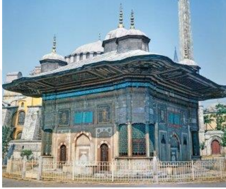
Şekil 1.14: Sultan III.Ahmed Çeşmesi (K: Url-4 )
