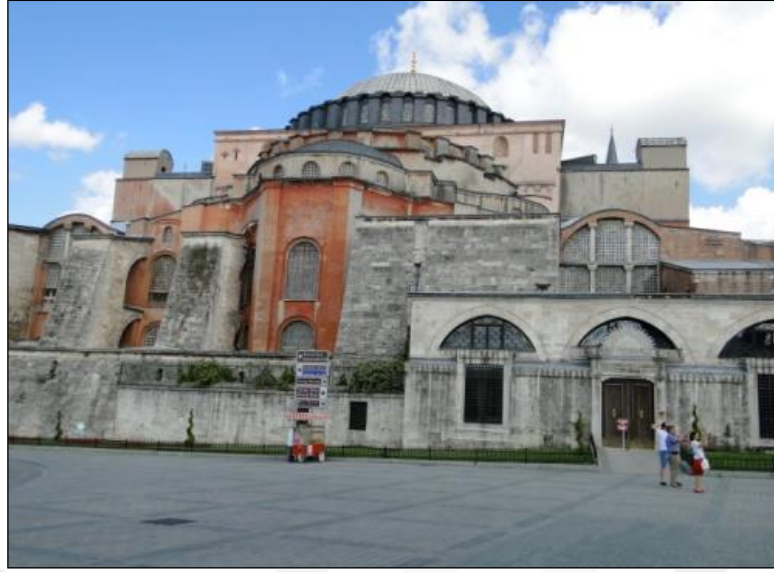
Şekil 3.28: Ayasofya'nın Doğu Cephesi (K: Ahunbay Z.)
